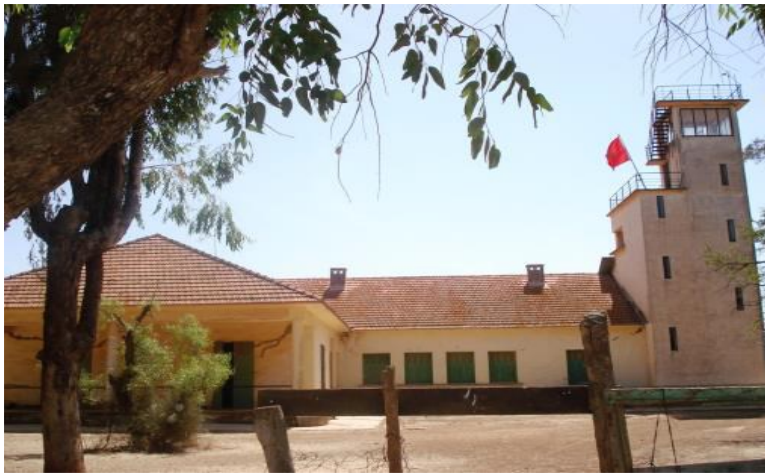
Figure 1. 4 : Observatoire Averroès (AVE) bâtiments principale
