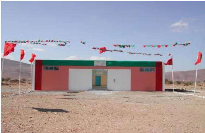
Figure 1. 6 : Le nouveau bâtiment de la Station de Recherches Présahariennes d'Aouinet Torkoz
