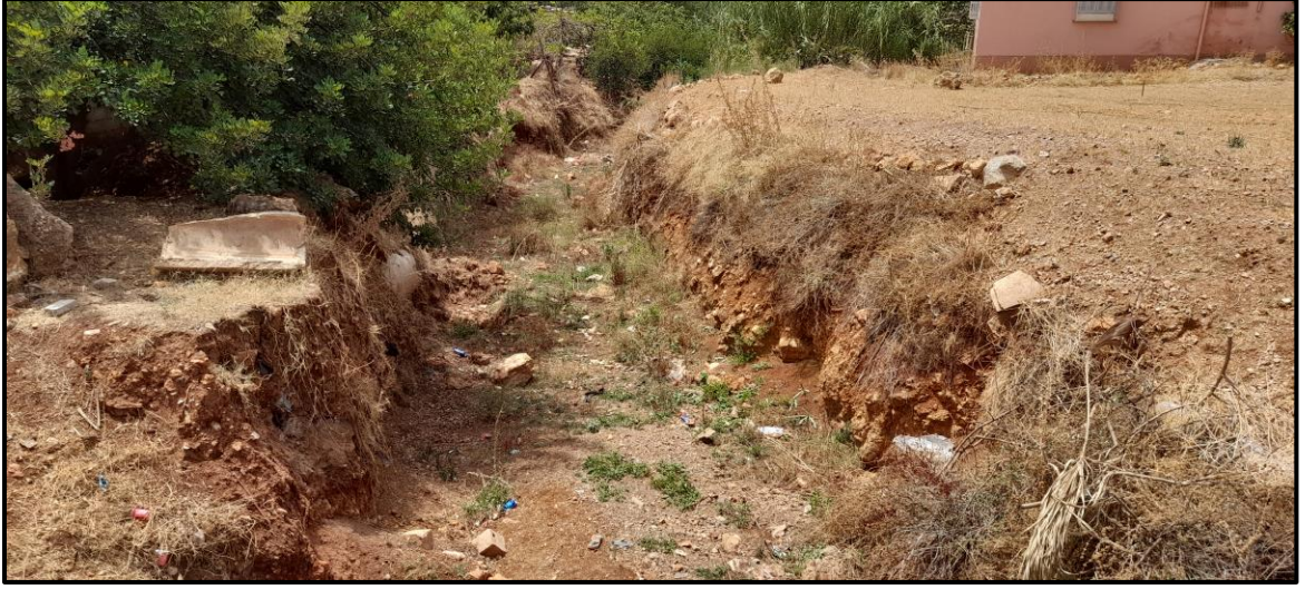
صورة رقم 56: توضع الأتربة داخل شعبة النهضة بعد إصلاحها
