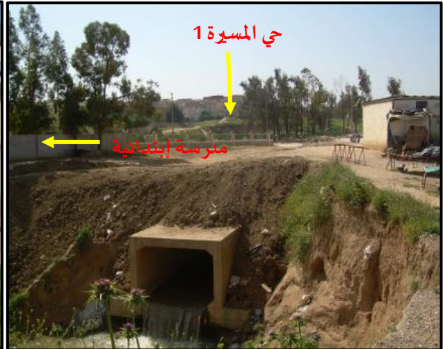
صورة رقم 51: قناة تصريف مياه واد جعونة لحماية حي القدس 1 من الفيضانات
