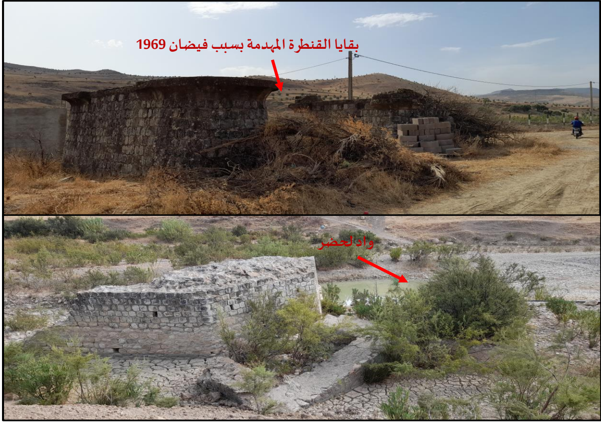
صورة رقم 41: انهيار القنطرة بفعل فيضان واد لحضر سنة 1969
