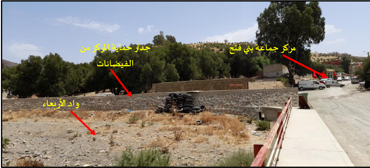
صورة رقم 54: جدار لحماية مركز بني فتاح من فيضانات واد الأربعاء
