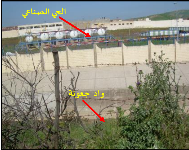
صورة رقم 52: جدار لحماية الحي الصناعي من الفيضانات واد جعونة
