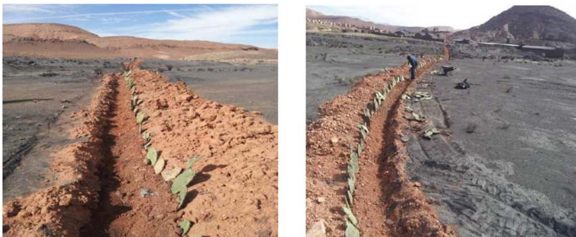
FIGURE 1.7: Réalisation d'une clôture verte par plantation d'arbres de cactus autour de l'aire de stockage du tout-venant (mine d'Imini)- SACEM, RAPPORT D'ACTIVITE 2013-
