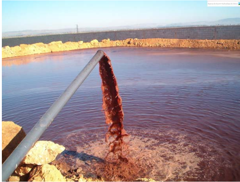
FIGURE 7.2: Bassin de stockage des margines, région de Fés (Agence du Bassin Hydraulique de Sébou)
