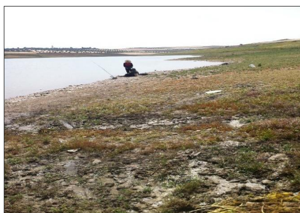
Photo 96: Barrage El Gaada sur l'oued Boufkrane (2015)
