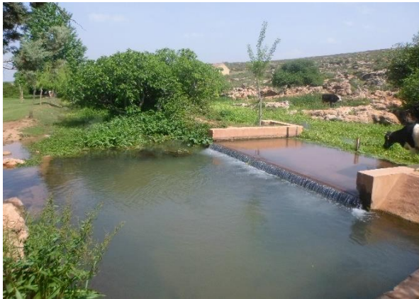
Photo 35: Déversoir à paroi mince, source Ribaa Amont. (29 fév. 2016).
