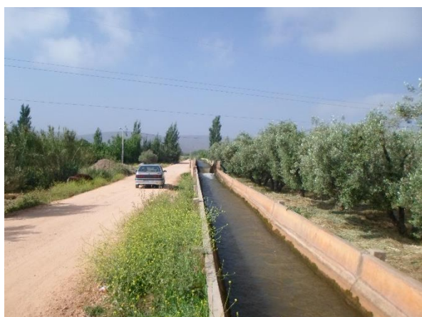
Photo 65: Dérivation des eaux de la source de Bittit vers une seguia. (25 mai 2016)
