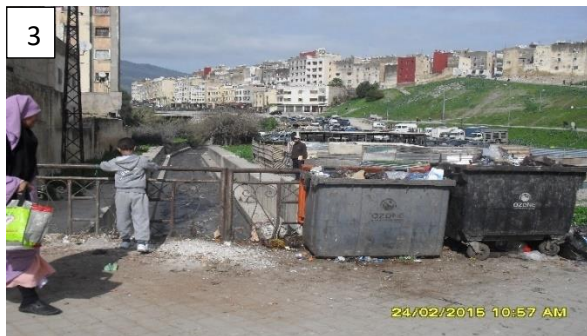
Photo 99: Oued Fès au niveau de Jen Chfour
