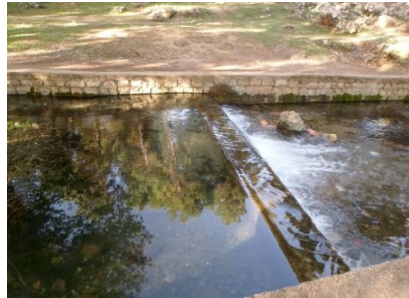
Photo 36: Déversoir à paroi mince, source Ain Sultane. (12 Avril. 2015).
