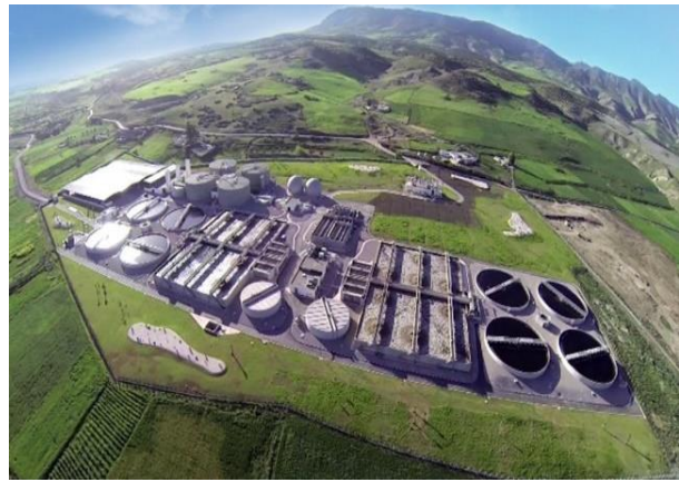
Photo 58: Station d'épuration des eaux usées de Fès STEP. (Www.radeef.ma)
