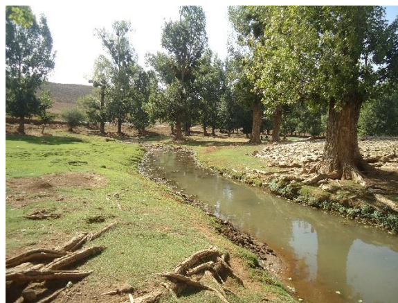
Photo 62: Oued Tizguit au niveau d'amont. (Sep. 2016)
