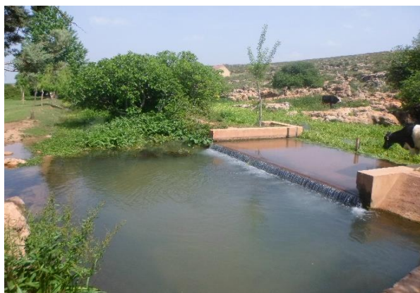
Photo 72: Ribaa Amont (29 février 2016)
