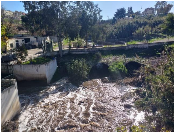
Photo 57: Station d'épuration des eaux au niveau de la médina de Fès. (15 Janv. 2020)
