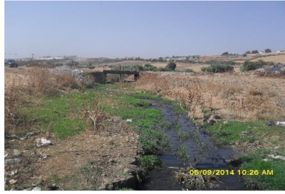
Photo 17: Oued Boufekrane (Aval l'entrée de la médina de Fès). ( 5sep. 2014)
