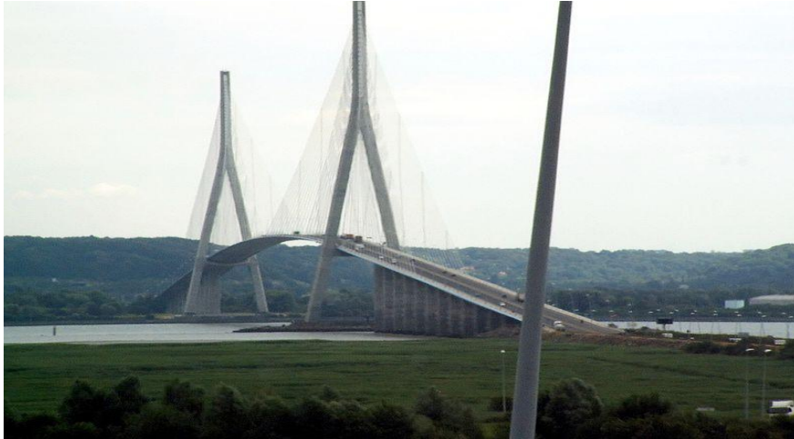
Pont de Normandie. Les voussoirs des rampes d'accès ont été fabriqués avec du BHP de résistance 60MPa.
