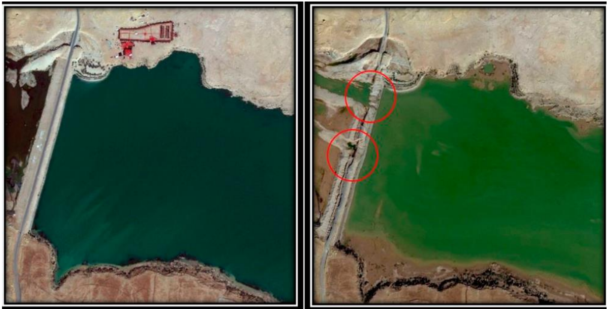
Figure 22. Barrage de Sakia El Hamra à gauche (septembre 2016), la crue éclair entraînant l'ouverture de deux brèches de 100 m dans le corps du remblai au niveau du lit mineur de l'Oued (représenté par des cercles à droite-image de la main, prise en décembre 2016)
