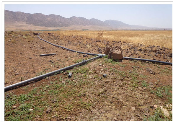
Photo 10.12 : Tuyaux d'acheminement de l'eau à partir des endroits où le niveau piézométrique est moins profond
