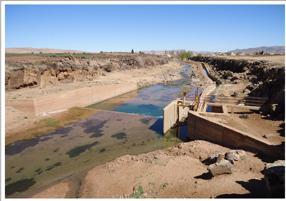
Photo 10.3 : Barrage de partage des eaux d'irrigation sur oued Guigou au niveau de Aït Hamza
