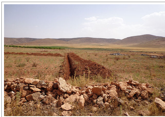
Photo 7.2. Fossé pour la mise en place du goutte-à-goutte
