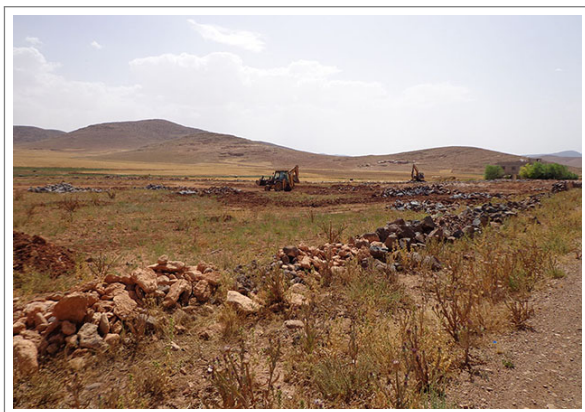
Photo 7.1. Travaux d'épierrage par l'utilisation des pelles mécaniques
