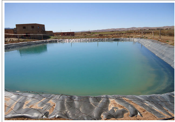
Photo 10.10 : Bassins de collecte de l'eau pompée à partir de la nappe
