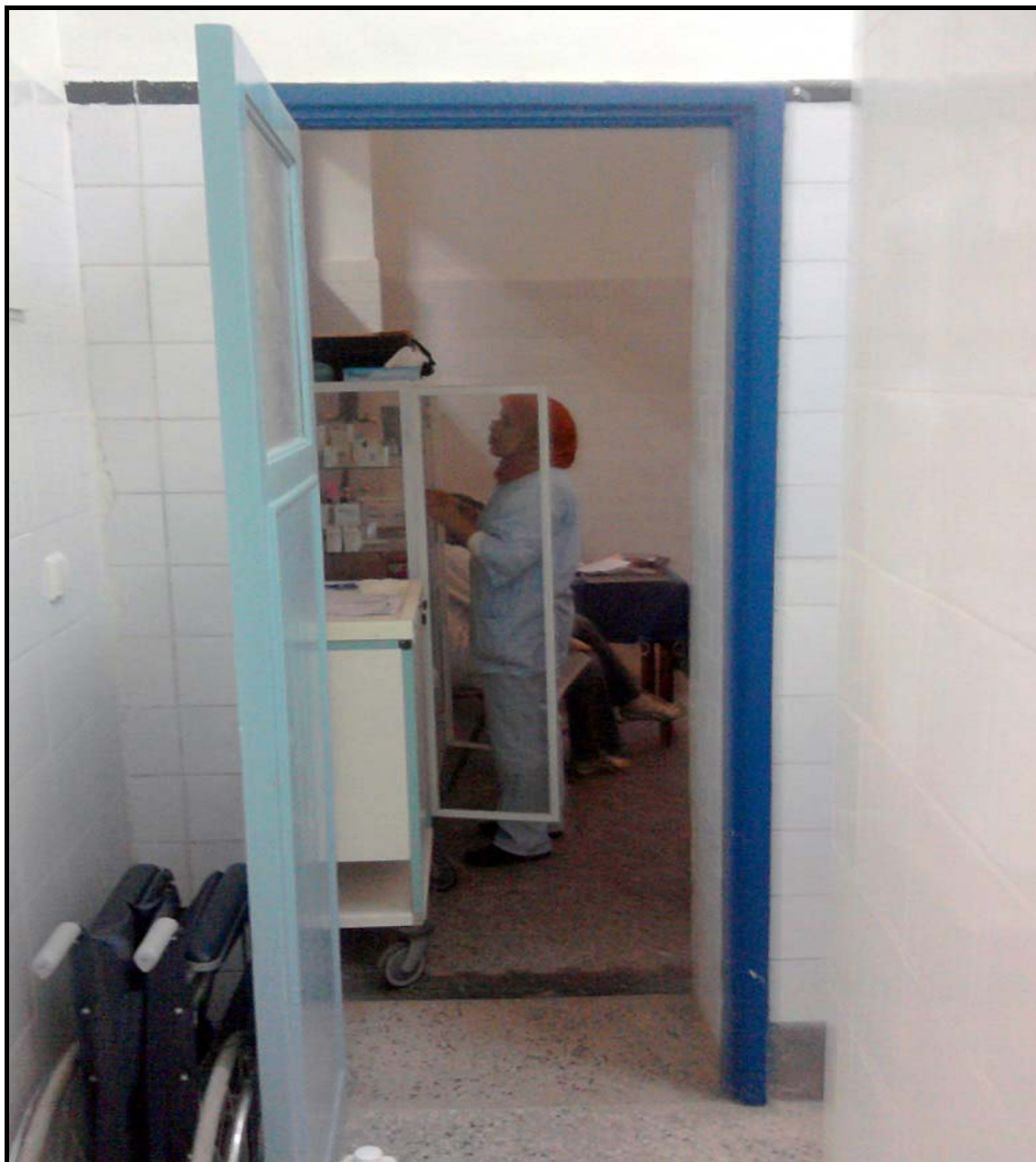
Figure 6 : Communication entre la salle d'endoscopie et la zone de désinfection et de stockage de l'unité d'endoscopie digestive du service d'HGE du CHU Med VI-Hôpital Ibn Tofaïl.
