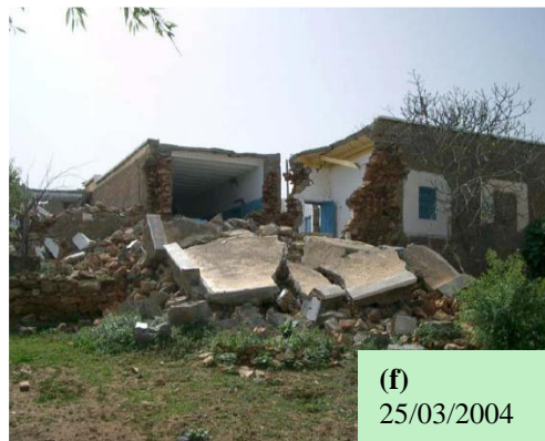
Figure 42: Données historiques de la vulnérabilité des structures après le séisme d'Al Hoceima du 24/02/2004 (a) : Dommages dans les coins des bâtiments dus aux forces horizontales, (b) : Dommages au niveau du RDC dus à une répartition non uniforme des efforts sur la hauteur du bâtiment (cisaillement des poteaux), (c) ; (e) : Poteaux courts, (f) ; (d) : dommages dus à la flexibilité du plancher et à la géométrie de la structure). Source : Séisme d'Al Hoceima (Maroc) du 24 février 2004 - Rapport de la mission AFPS
