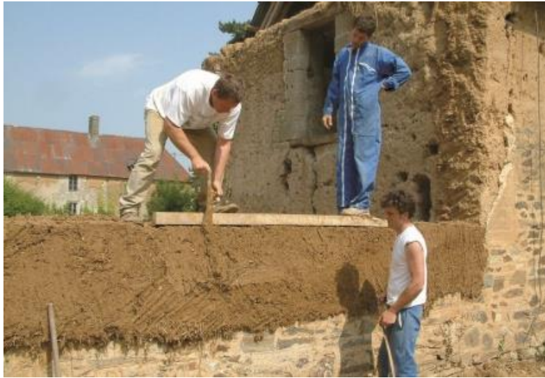
Figure 3. La construction par la bauge.
