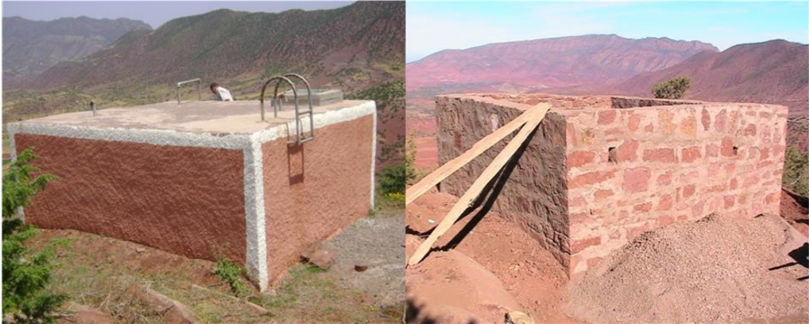
Planche photo 5 : la construction de château d'eau à douar Ikhachane, construction destinée à entreposer l'eau, placée en général sur un sommet géographique pour permettre de la distribuer sous pression
