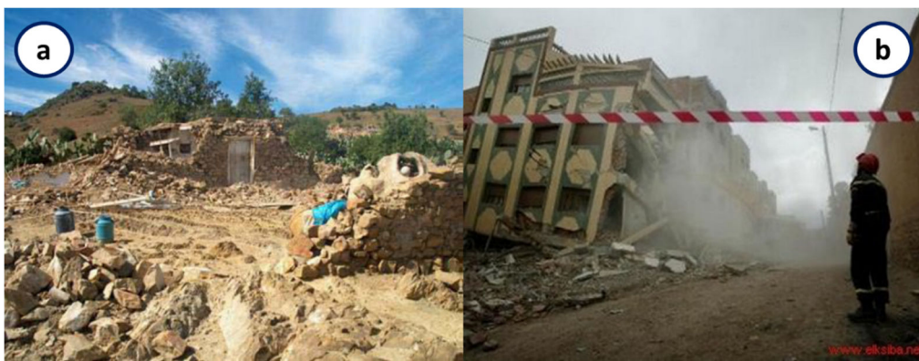
Figure II-27. Exemple de cas de dommages des constructions en milieu rural (a- Aït Kamra) et urbain (b- : Imzouren) dans la région d'Al Hoceima - séisme du 24 Février 2004.
