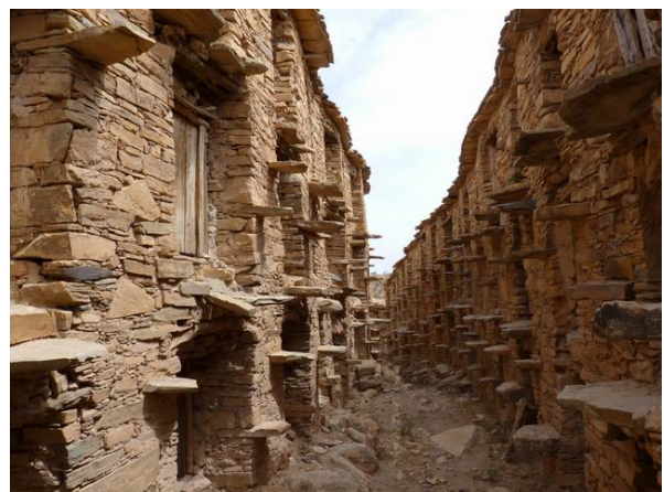
Photographie 2 : Grenier collectif Agadir Inoumar – Anti-Atlas occidental
