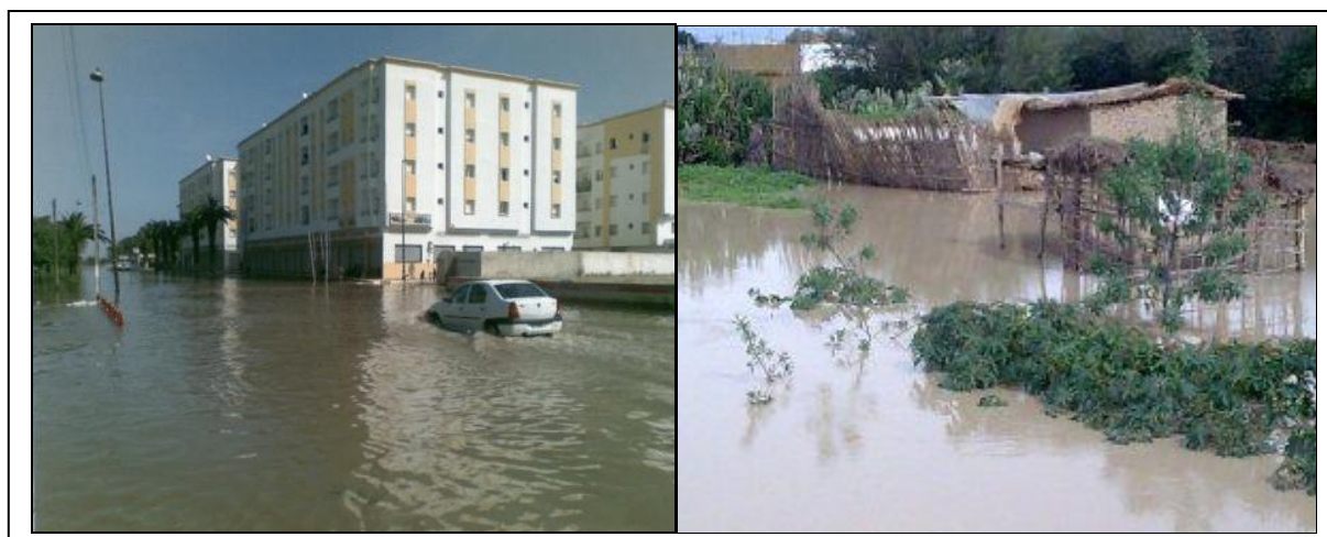
Photos. n°16: Inondations des zones bâties dans le Gharb (Merjet Fourat et Hawafat, 2010).
