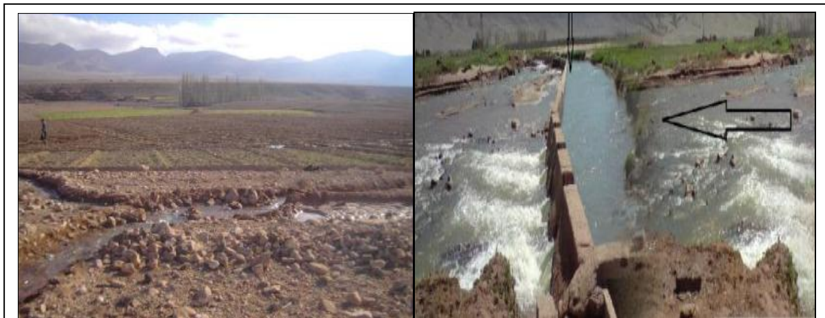
Photos. n°10: Système de gravité pour dévier les eaux vers les champs agraires irrigués par « Seguia » (Moyen Sebou).
