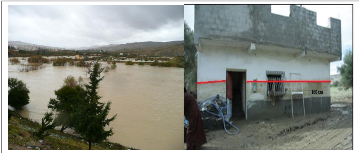
Photos. n°12: Importance de crue de l'oued Inaouene et Hauteur d'eau des inondations à 160 cm dans la ville de l'Oued Amlil le 10 mars 2010.
