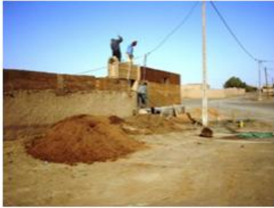
Mode de construction en Pisé (Merzougga-Errachidia)
