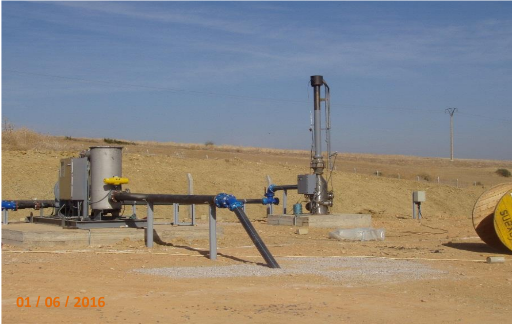
صورة رقم 9: توضيح طريقة استخلاص البيوغاز التي تعتمد على التخمر اللاهوائي للمخلفات الصلبة والسائلة بالمطرح العمومي للنفايات بفاس.
