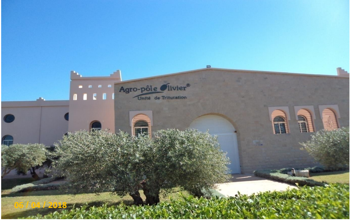
الصورة رقم 5: قطب البحث في مجال الزيتون.
