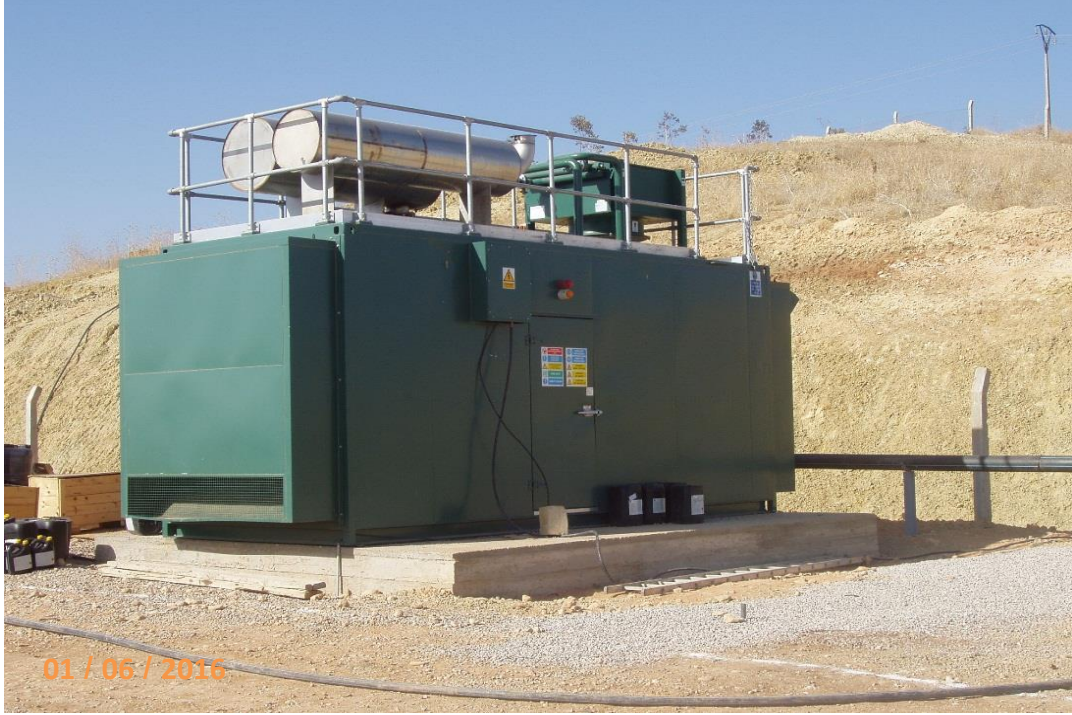
صورة رقم 10: مولد يعمل بالبيوغاز لإنتاج الطاقة الكهربائية بالمطرح العمومي للنفايات بفاس
