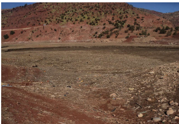
Photo 15 : remplissage du barrage par des sédiments au niveau de la partie amont du barrage
