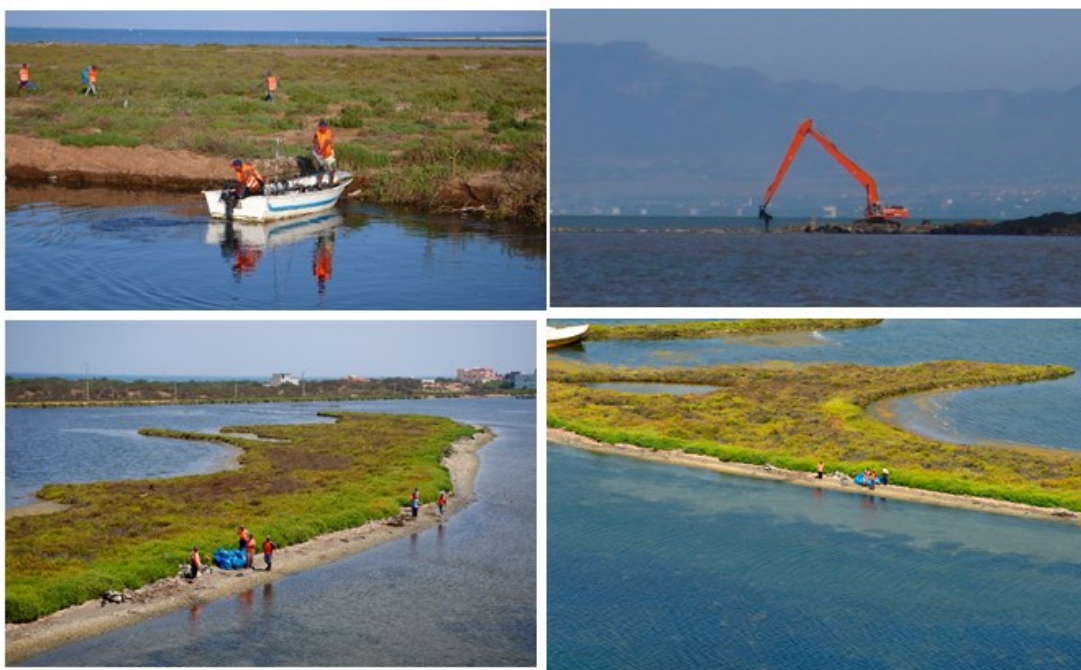
Figure I-19 : Photos montrant les travaux de dépollution des eaux de la lagune de Marchica. ( http://agencemarchica.gov.ma/ ).
