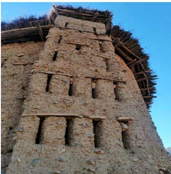
Planche 8: Les petites ouvertures sur les façades des murs d'Ighrem N'Sidi Moussa, 2020
