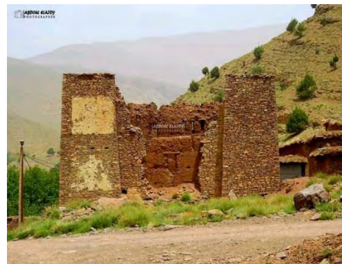
Photo 25: Dégradation des murs 2019
