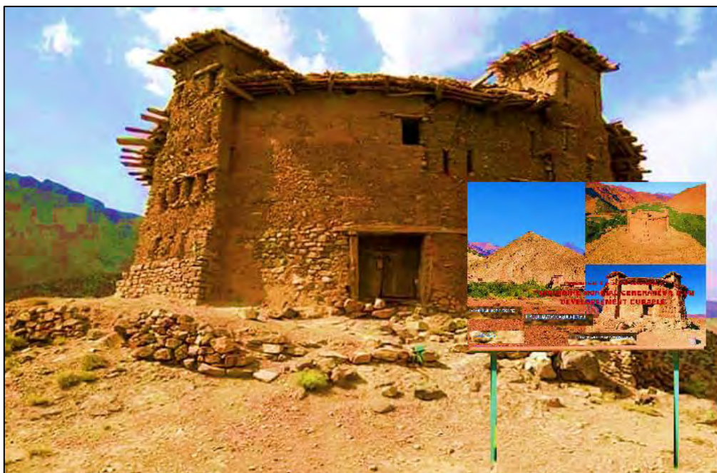
Figure 73: Emplacement du panneau didactique sur le grenier de Sidi Moussa ,2020
