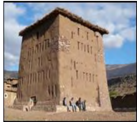
Photo 30:Le grenier collectif d'Ibaqalliwn après la restauration
