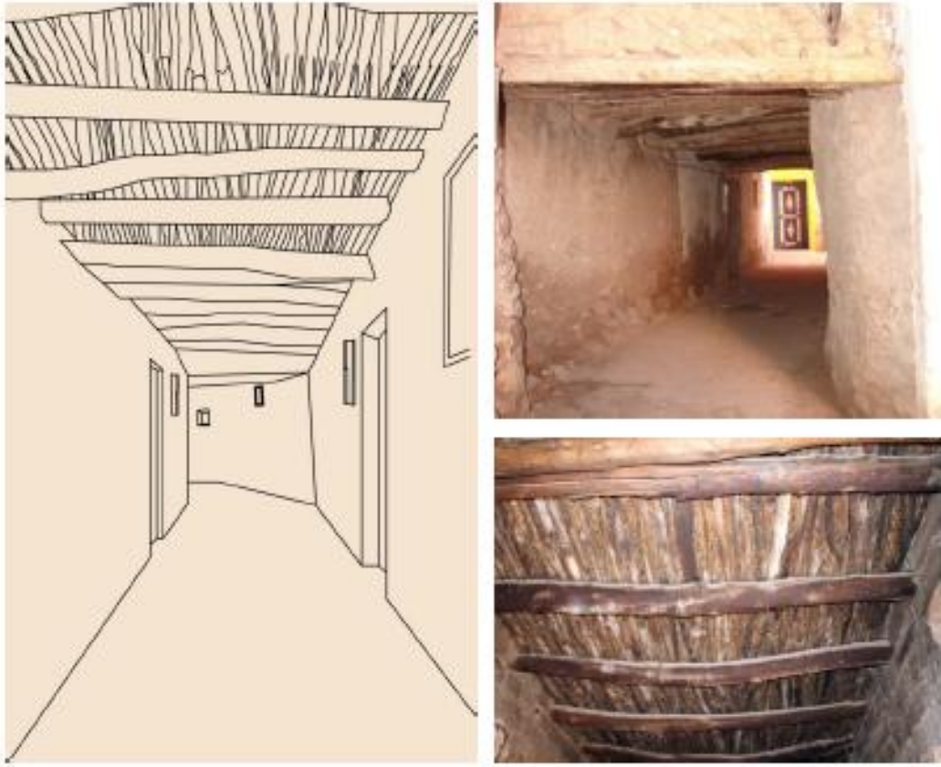
الشكل 1: استعمال الخشب لتسقيف الأزقة والشوارع بدمنات
