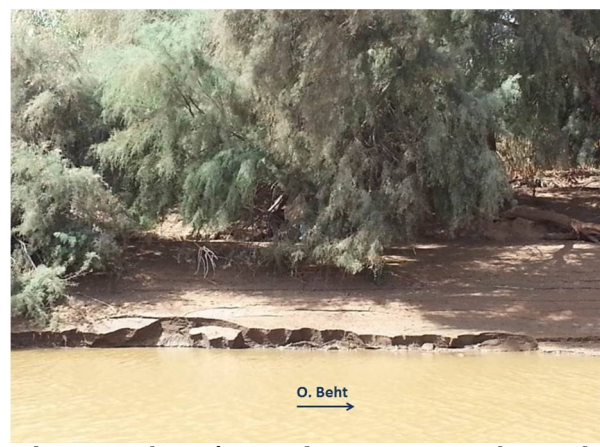
d.- Berges basse à pente douce en rive gauche - aval du pont RR701 (13/9/2017)
