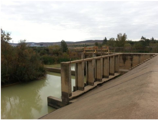
a./Barrage de dérivation des eaux à Bouharmel
