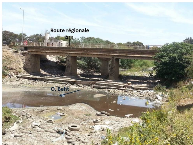
a./Seuil dissipateur d'énergie au niveau du pont de la RR411 à Dar El Gueddari (1/6/2016)
