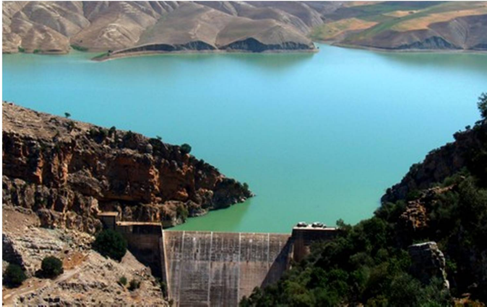
Photo.6.4. La retenue du barrage El Kansera dans la vallée du Beht ( http://www.maroc-trip.com )
