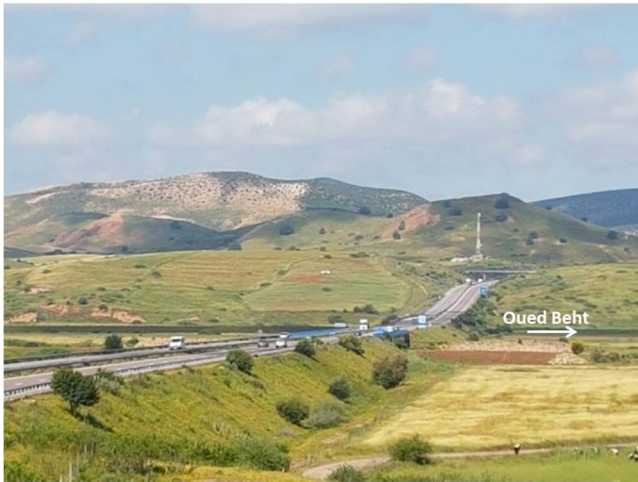
a.- Autoroute Rabat-Fès traversant la plaine alluviale du Beht (4/5/2018)
