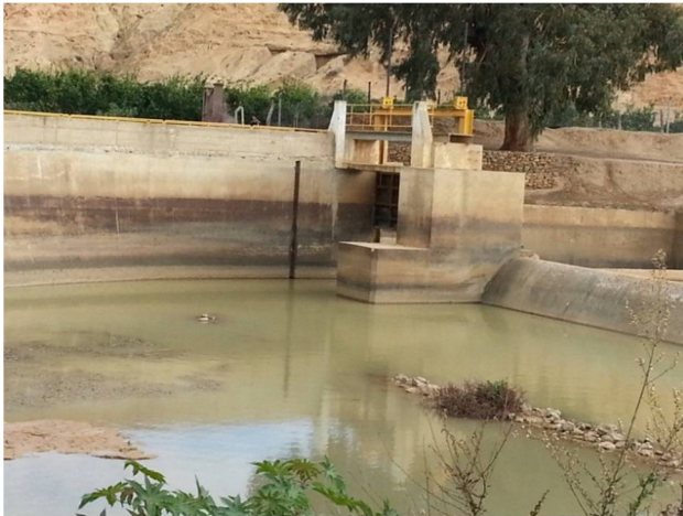
b./Barrage de compensation des eaux et canal de dérivation des eaux à Kaf Nsour
