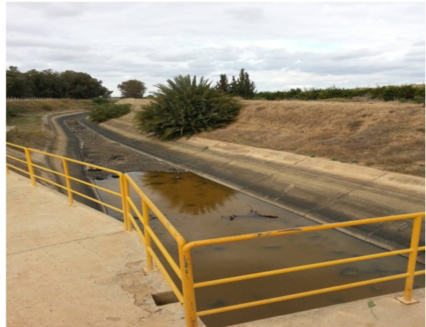
c./Canal de dérivation des eaux à Kaf Nsour
