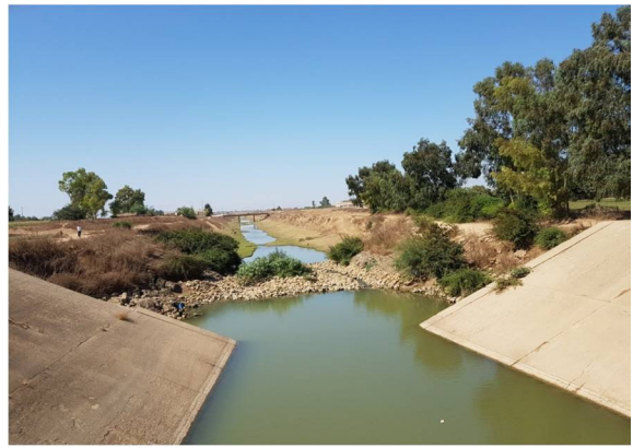
b. L'aval du canal de transfert des eaux Beht-Sebou
