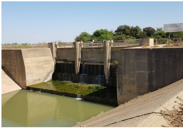
a. Tête du canal de transfert des eaux Beht-Sebou
