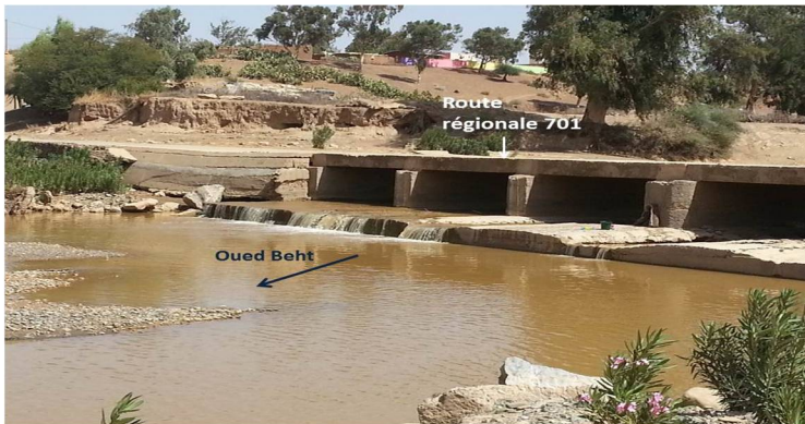
Planche photos. 6. 1. Seuil dissipateur d'énergie en aval du pont de la RR701
