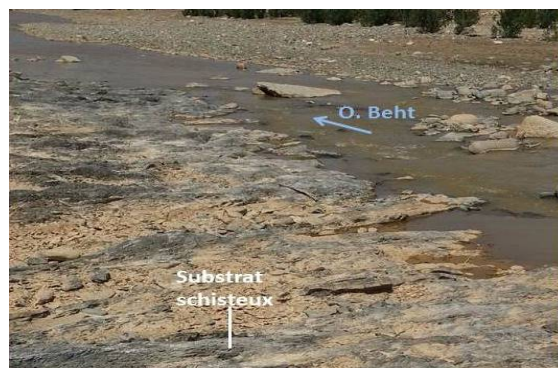
b.- Affleurement du substratum schisteux au fond du lit mineur (cas observé en aval du pont RR701) (13/9/2017)
