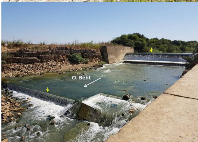
b./ Seuils du déversoir sur le Beht en aval de douar Oulad Rahou (15/10/2018)
