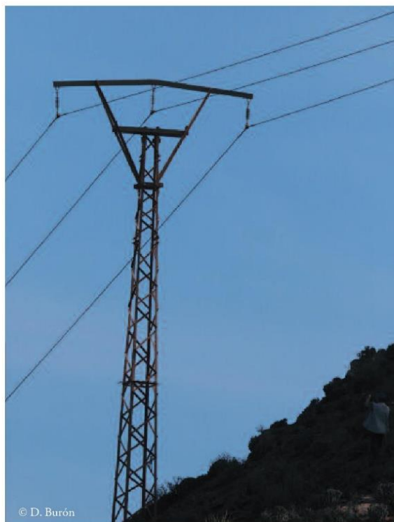
Figura 20. Apoyo tipo P-02 a), una variante del apoyo de bóveda con la parte superior del poste muy cercana al conductor central. Presente principalmente en la Línea A, presenta el mayor índice de peligrosidad por tipo de apoyo.
