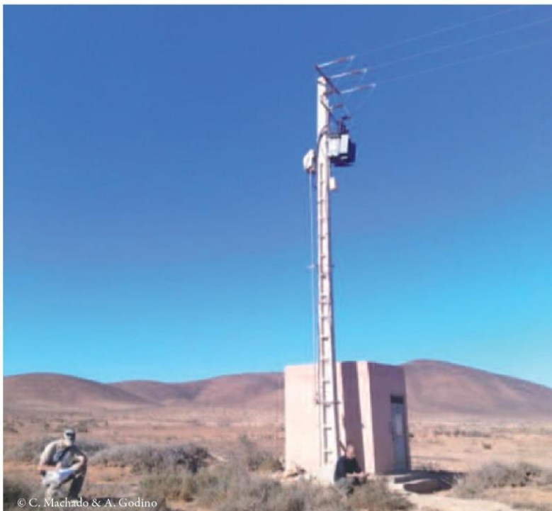
Figura 35. Apoyo tipo P-15, con seccionador tripolar en vástago (B2-006), y en este caso fin de línea con transformador, donde se encontraron dos halcones borries ( Falco biarmicus ).
