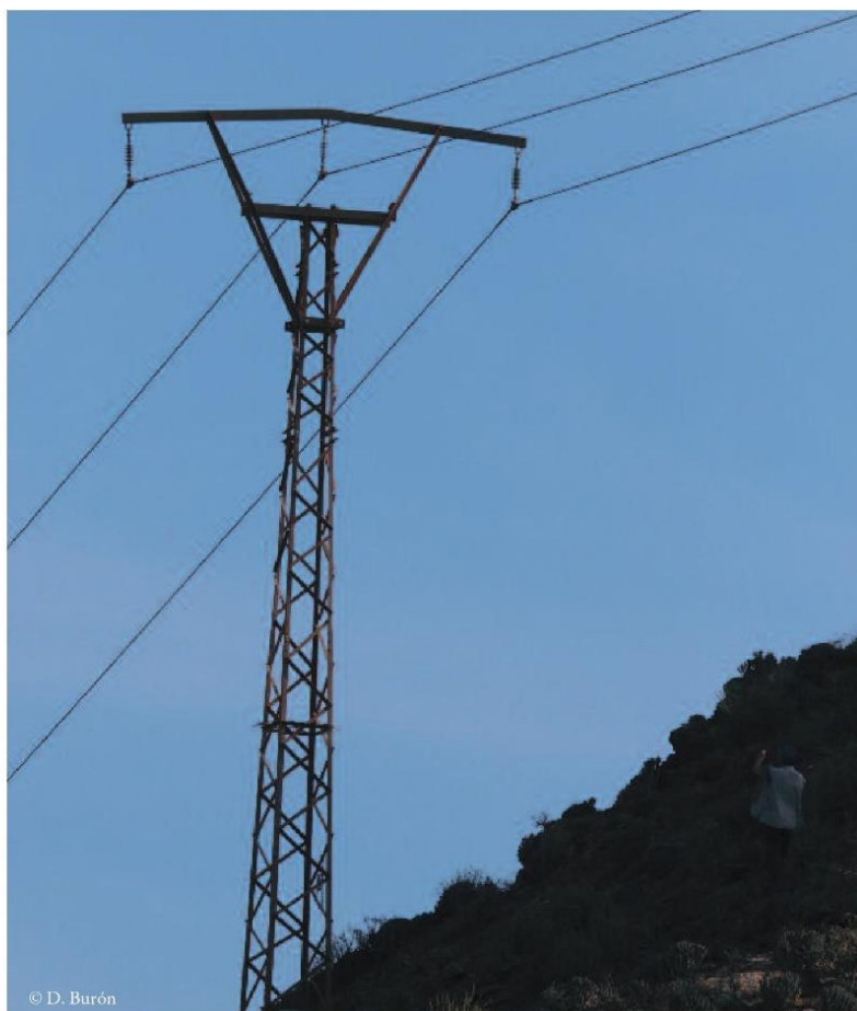
Figura 30. Apoyo tipo P-02 a), una variante del apoyo de bóveda con la parte superior del poste muy cercana al hilo central (A-042). Presente principalmente en la Línea A, presenta el mayor índice de peligrosidad por tipo de apoyo.
