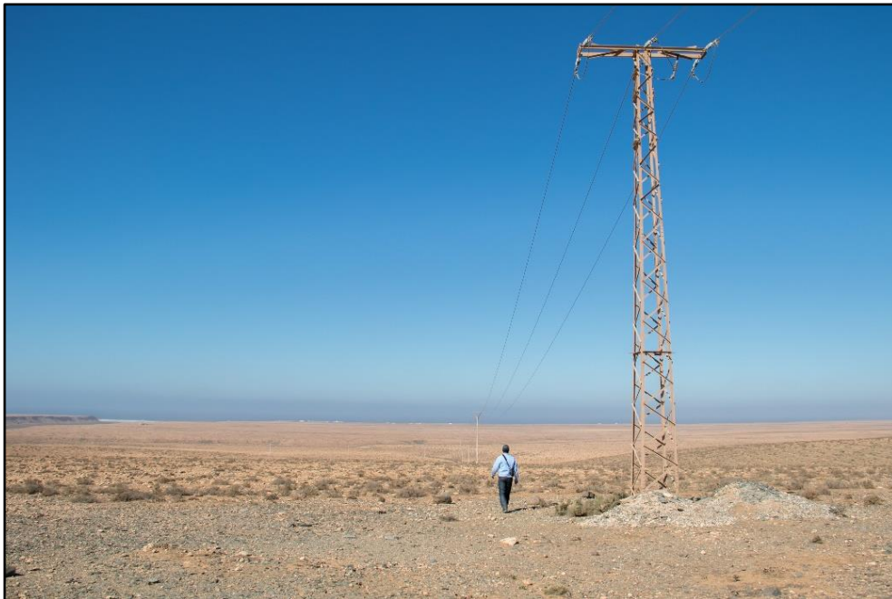
Figure 43 : Prospection à pied le long d'une ligne électrique (2016) (A. Irizi ©).
