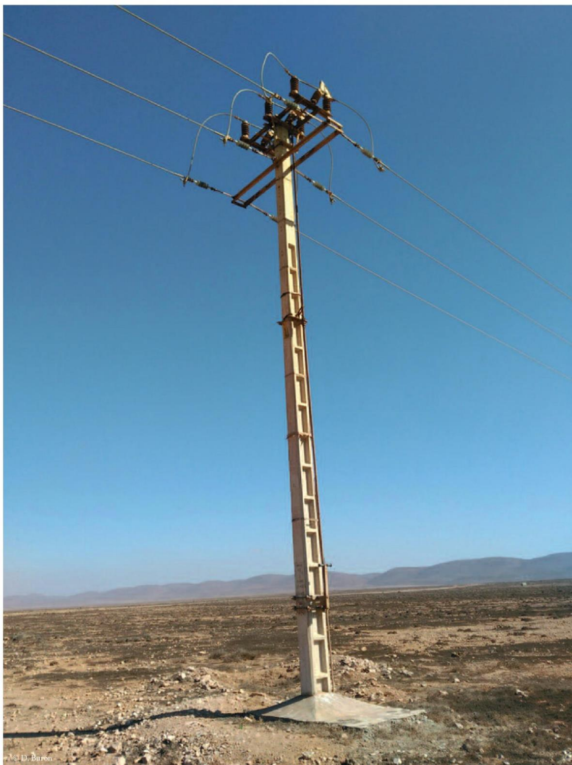
Figura 36. Apoyo tipo P-16, con seccionador tripolar en cabecera (A-002). Figure 36. Pylône de type P-16 avec sectionneur tripolaire au sommet (A-002).
