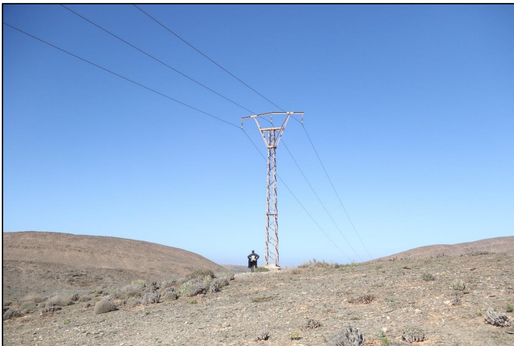
Figure 33 : Exemple d'un poteau se trouvant dans un point culminant. (A. Irizi ©)
