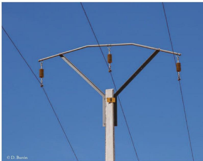
Figura 29. Apoyo tipo P-02, con poste de hormigón (D-016).
