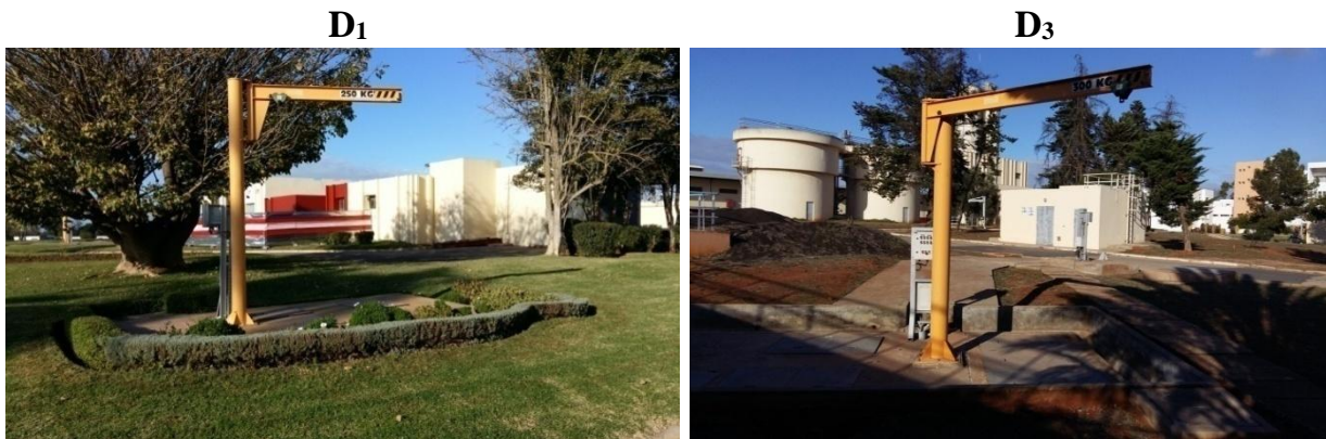
Figure 1.19. Postes de pompage D 1 , D 3 .
