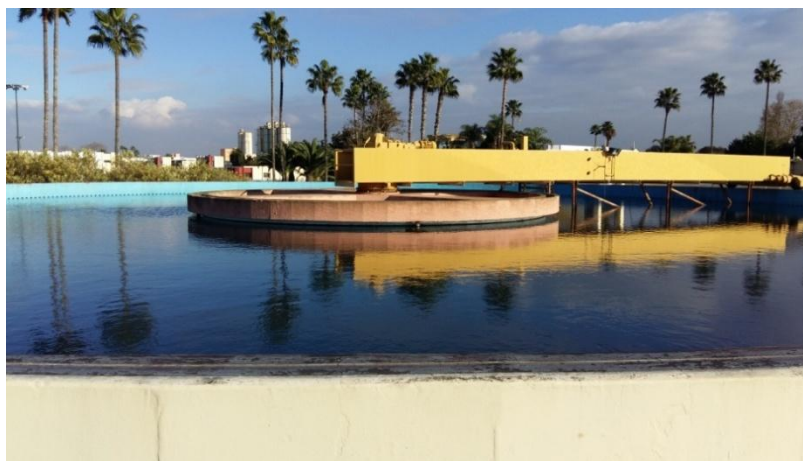
Figure 1.6. Décanteur circulaire avec raclage.
