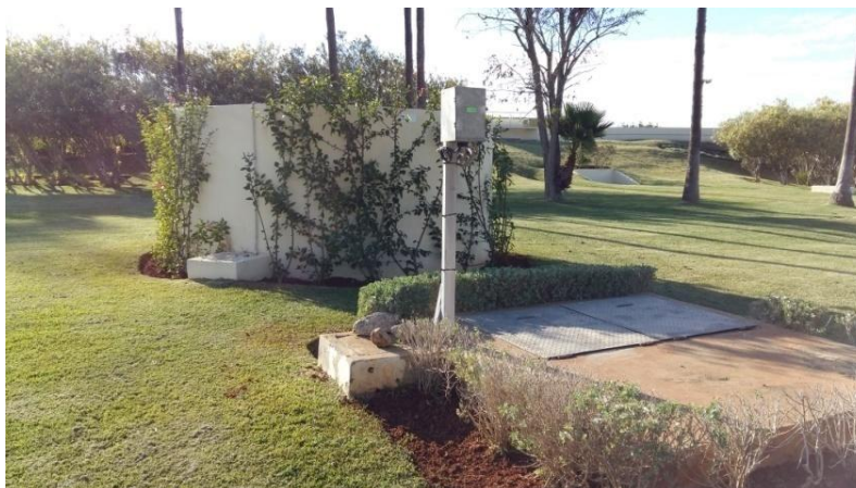
Figure 1.12. Cheminée de mise en charge.
