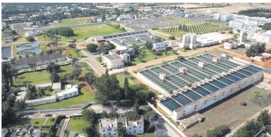
Figure 1.1. Station de traitement d'eau potable du complexe Bouregreg.
