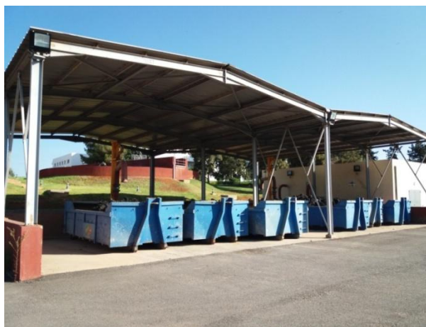
Figure 1.26. L'aire de stockage.
