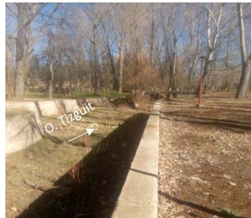
Bétonisation et enrochement des berges de l'Oued Tizguit aux environs d'Ifrane (Décembre 2021).
