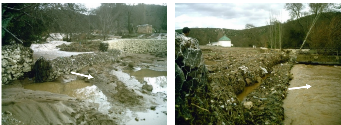
Planche photos 2.1 : les crues de l'Oued Mikkès amont et endommagement des aménagements de protection au niveau du Zaouia Sidi Abdeslam en 2009.
