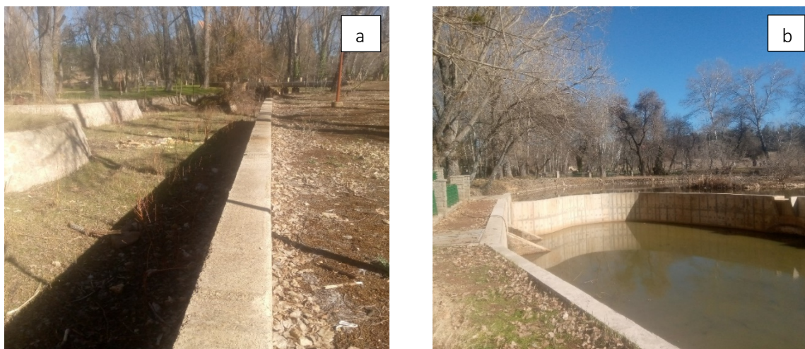
Planche photos 6.3 : canalisation et bétonnisation du lit de l'Oued Tizguit. a) au niveau du périmètre urbain de la ville d'Ifrane ; b) en aval du lac d'Ifrane (05/04/22).
