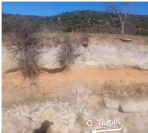
Berge non végétalisée entaillée dans les limons de la plaine alluviale à Zaouïa Sidi Abdeslam (Octobre 2019)
