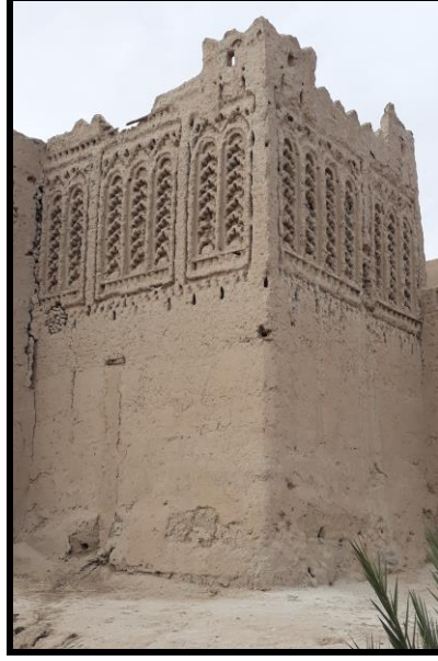
البرج الركني الشمالي الشرقي لقصر مزكيدة
