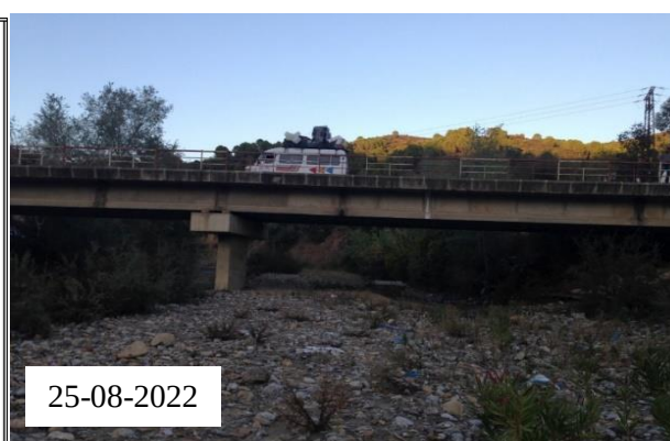
Photo 4. 6 - Situation du pont de mosquée (RR508).
