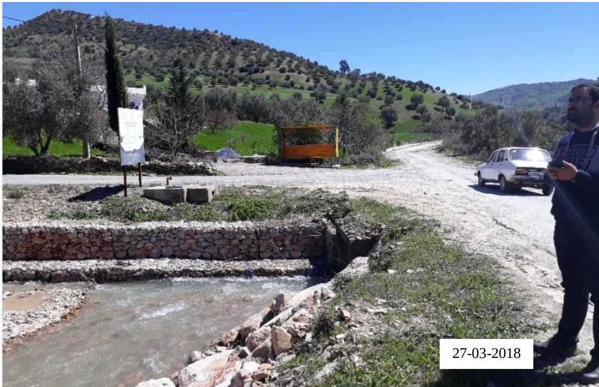
Photo 6. 14 - Protection de berge sur Oued El Khemis.
