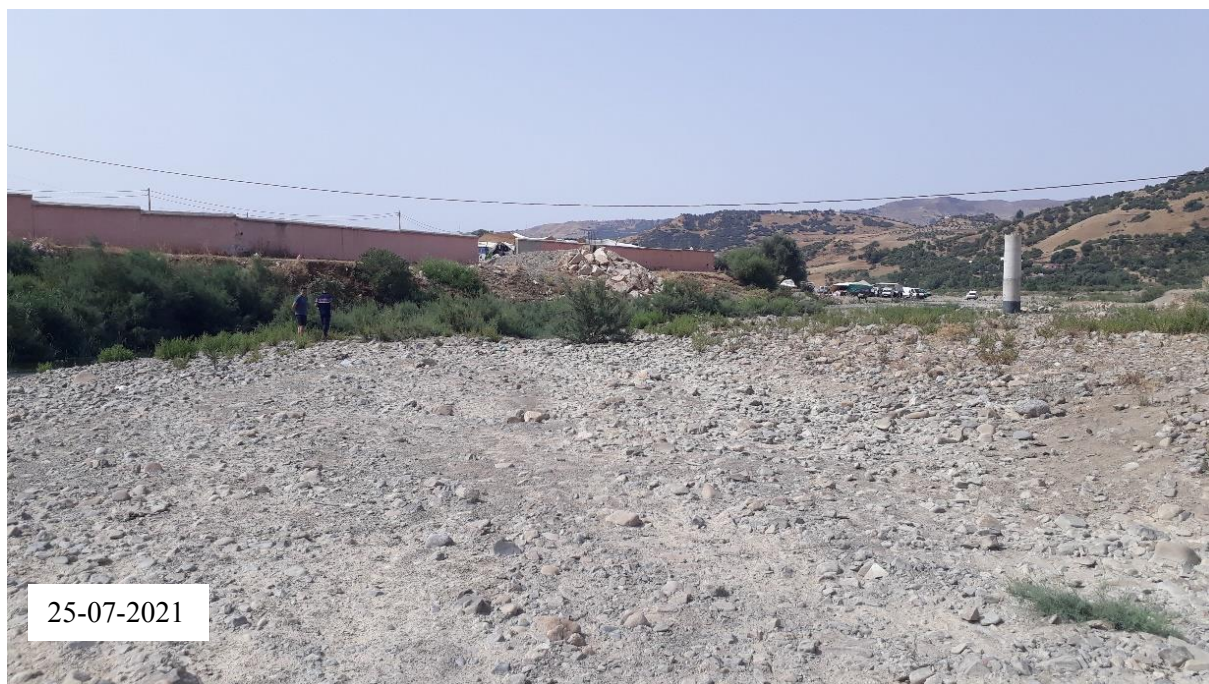
Photo 5. 1 - Construction du nouveau souk hebdomadaire à la surface du lit 3 de l'Oued Lahdar (rive gauche).
