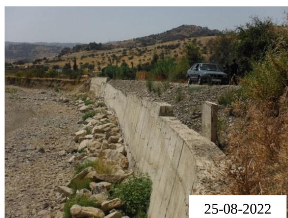
Photo 6. 18 - Morphologie et aspect des talus et des lits en rive droite de l'Oued à l'intermédiaire de C.R de Had Msila.
