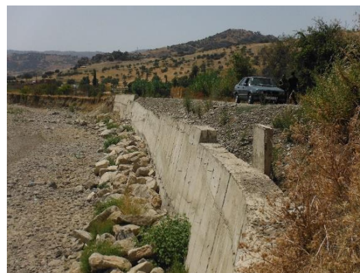
Photo 4. 7 - Situation du mur de soutènement qui protège la route RP5414.
