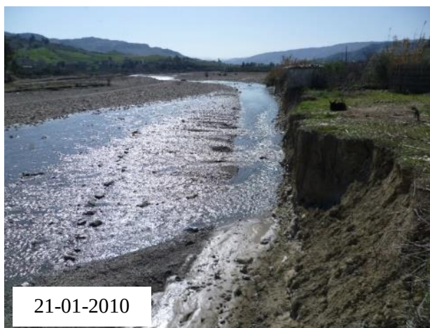
Photo 6. 10 - Situation de rive droite de l'Oued Lahdar avant la construction de la digue.
