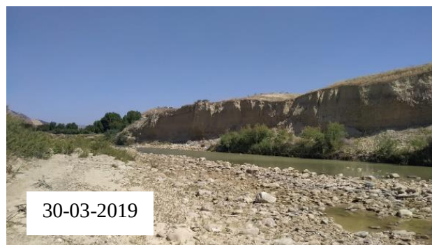
Photo 6. 22 - Morphologie et aspect des talus et des lits en rive gauche de l'Oued au niveau de Meknassa El Gharbiya.
