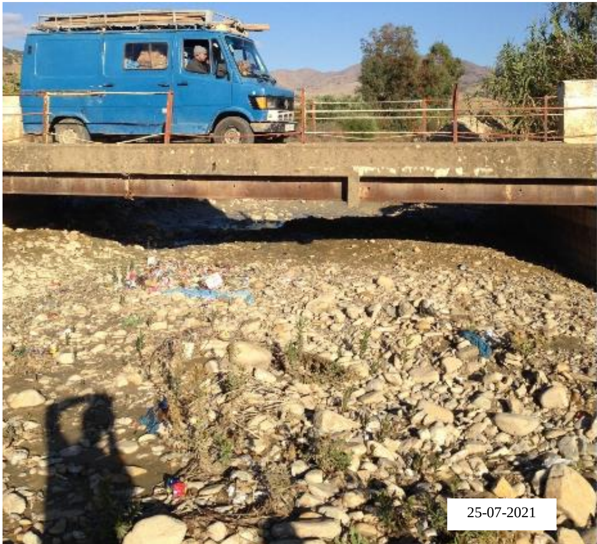
Photo 6. 13 - Situation et état du pont de l'Oued Rhnalla (près de confluence de L'Oued Lahdar) reliant le sud et ouest du BV.
