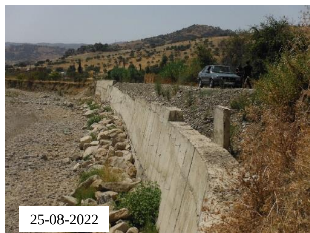
Photo 6. 11- Situation de rive droite de l'Oued Lahdar après la construction de la digue.
