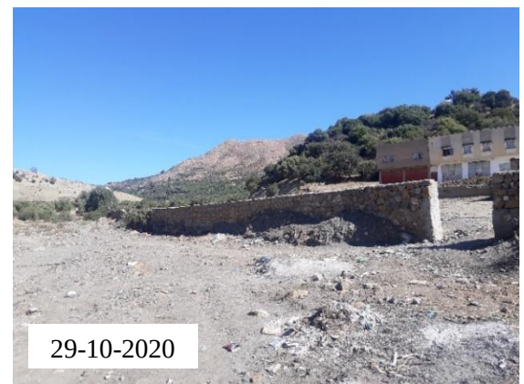
Photo 4. 5 - Situation du mur de soutènement de Souk Bni Ftah.
