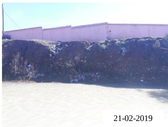
Photo 6. 17 - Morphologie et aspect des talus et des lits en rive gauche de l'Oued à l'intermédiaire de C.R de Had Msila.
