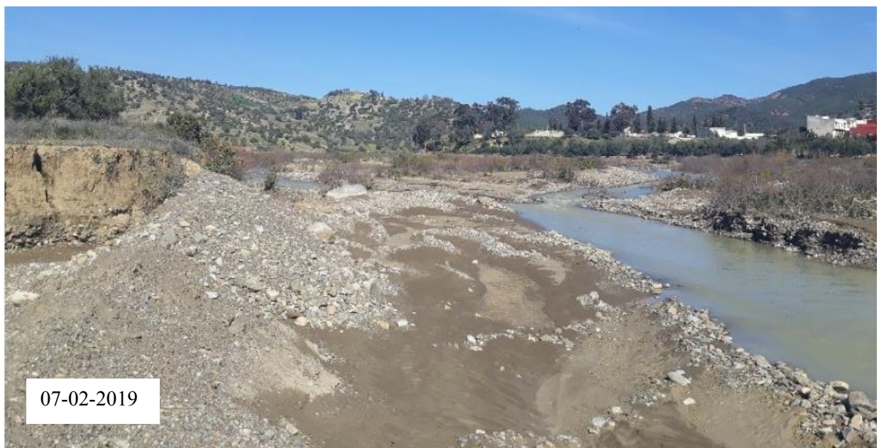
Photo 5. 2 – Impacte des remblais sur le changement du tracé de chenal de l'Oued Lahdar au niveau de C. Had Msila.
