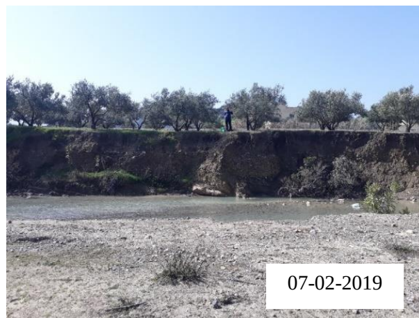
Photo 6. 16 - Morphologie et aspect des talus et des lits en rive droite de l'Oued à l'amont de C. Had Msila.
