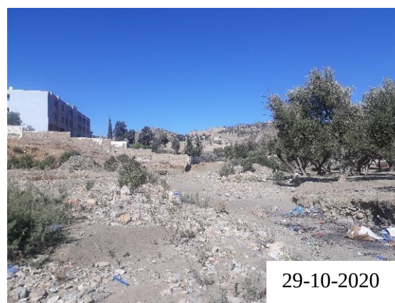
Photo 4. 8 - Situation du collège qui se situait près de la rive gauche d'Oued Bni Ftah.
