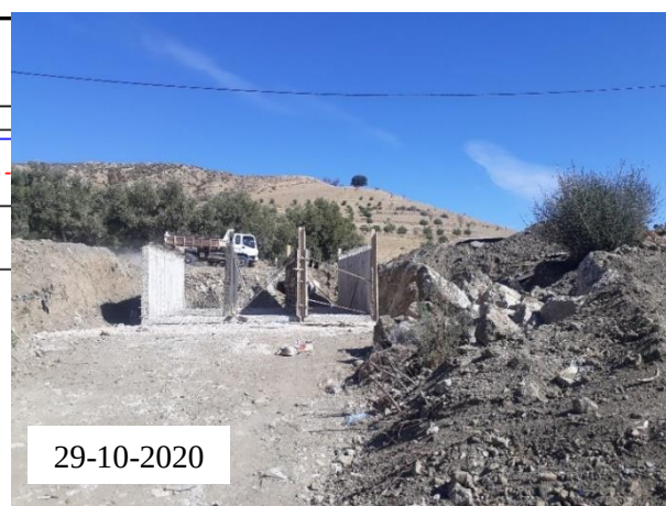
Photo 4. 2 - Situation du pont ( x : 626, y : 433 ), à l'entrée de Centre de Bni Ftah.
