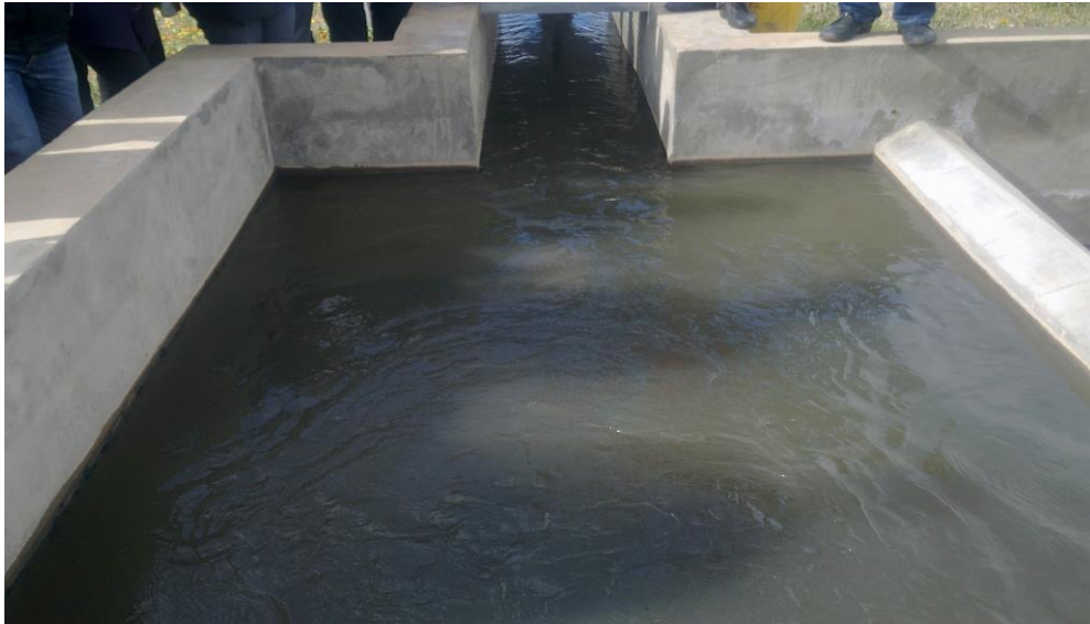
Photo 2 : Deuxième étape du prétraitement (désableur, STEP de Boujaâd)
