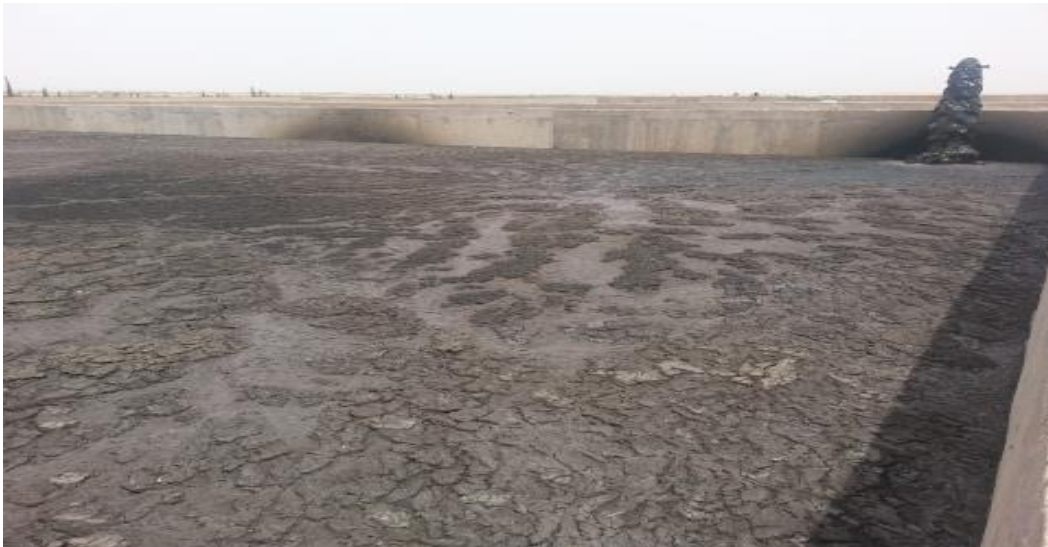
Photo 7 : Lit de séchage des boues extraites de la STEP de Boujaâd
