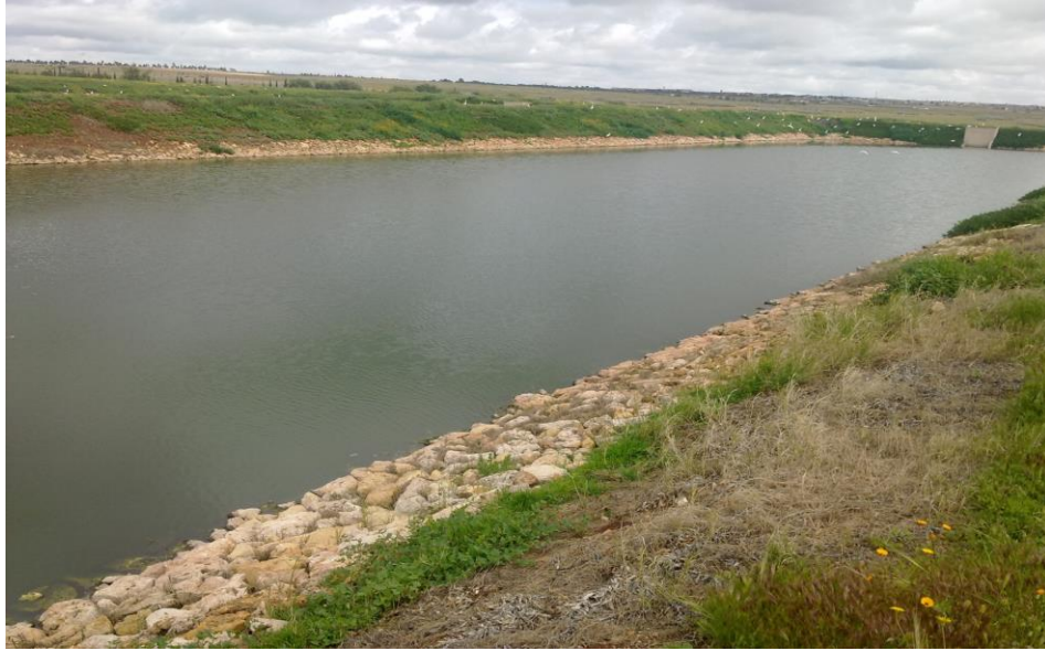
Photo 6 : Bassin du traitement tertiaire (STEP Lagunage de Boujaâd)
