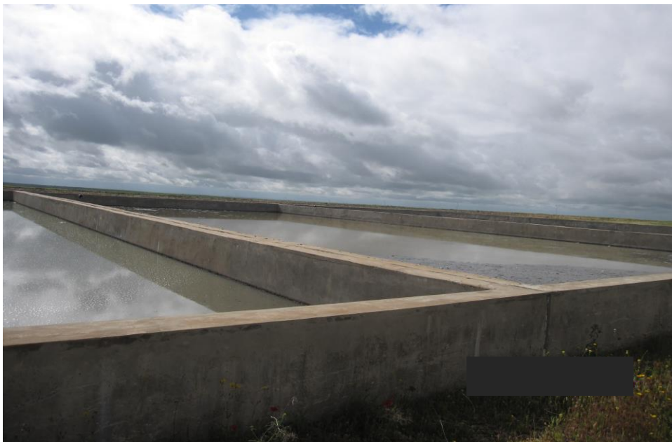
Photo 4 : Bassins du traitement primaire (STEP de Boujaâd)
