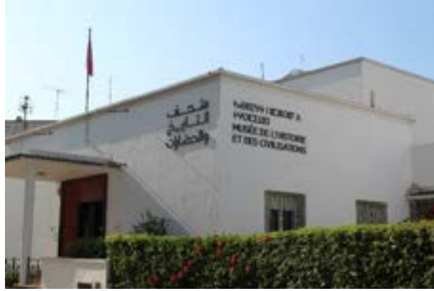
الصورة 02: الواجهة القديمة/الجديدة للمتحف الأثري بالرباط
