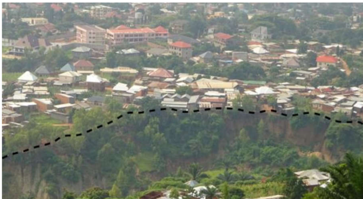
Figure IV-13: Menace du quartier Gikungu rural par un ravin affecté par des mouvements de masse avec des risques d'effondrement des maisons situées au-dessus du bord principal (ID=994)
