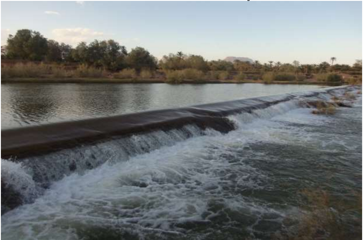
Photo n° 4: barrage de dérivation traditionnel « Ougougue » - Dourat : Oasis de Tinzouline-Drâa moyen.
