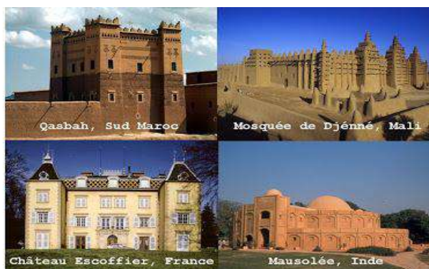
Figure 23. Constructions réalisées en blocs de terre comprimée.
