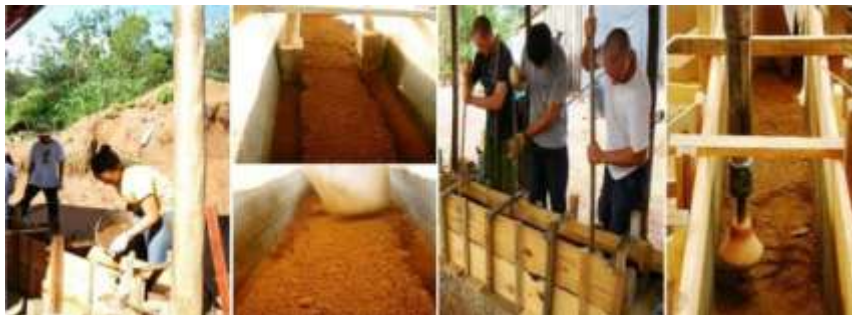
Figure 18. Etapes de construire un mur en pisé.
