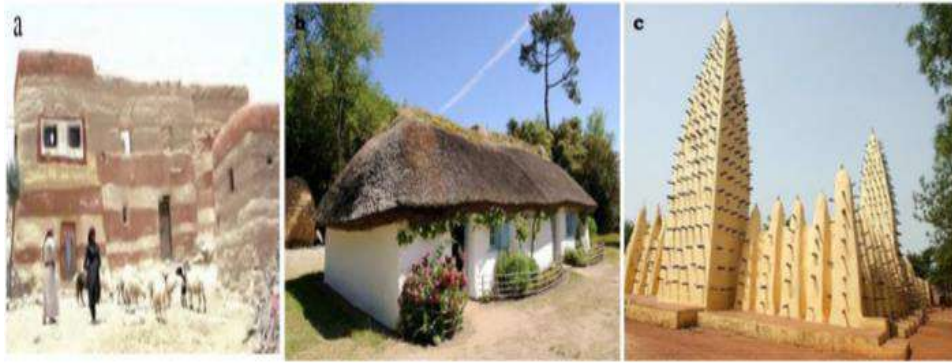
Figure 21. Construction en terre empilée : (a) maison à sadah Yémen, (b) Bourrine de Vendée ; (c) mosquée de Bobo Dioulasso.
