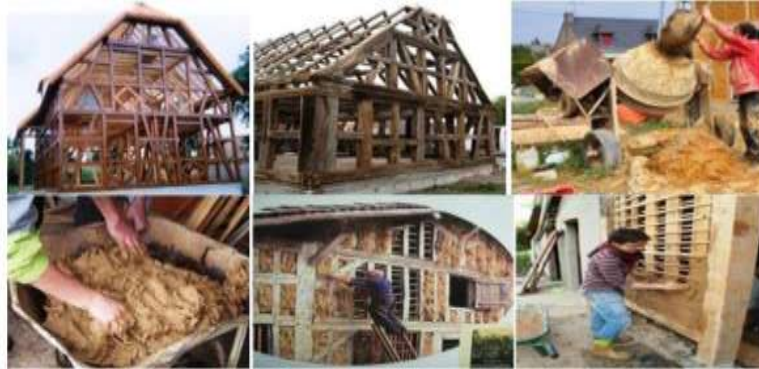
Figure 19. Techniques de construction en torchis alsace France.
