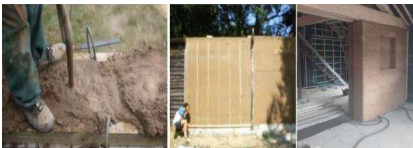
Figure 20. Exemple de mur en terre coulée.
