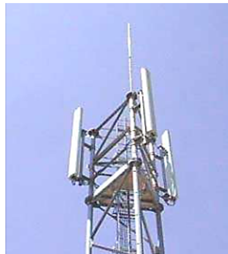
3 antennes directionnelles pour macro cellule
