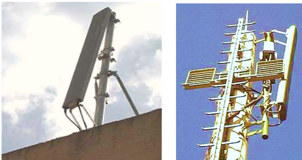
Fig. 6 : Antenne directionnelle avec un tilt positif (à gauche) et un tilt négatif (à droite) [5].
