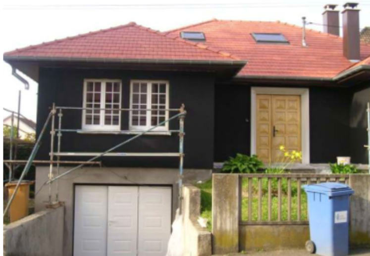
Figure 20 : Mise en œuvre extérieur de la peinture anti-onde [197].
