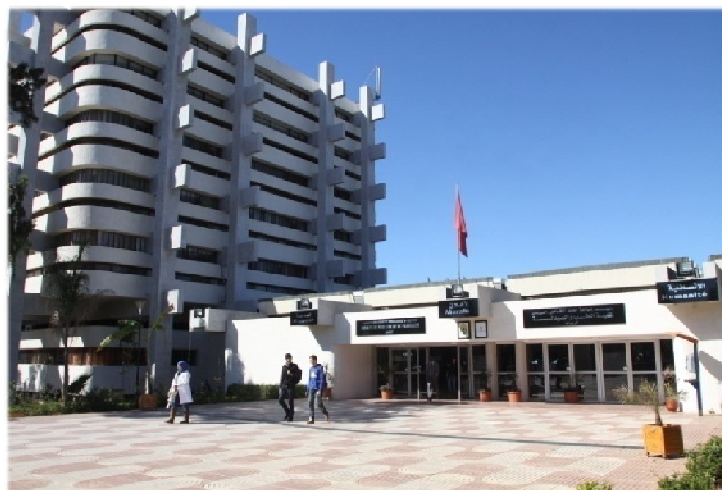
Figure 6 : Entrée du local actuel de la FMPR
