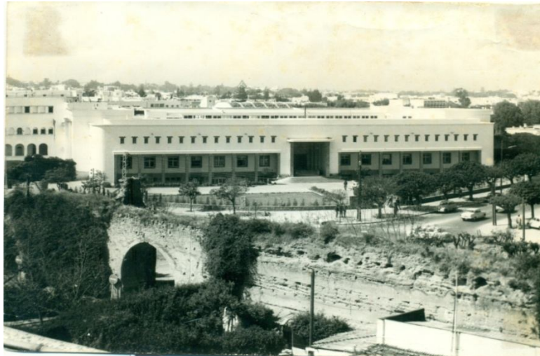
Figure 3 : Ancien local de la FMPR 6
