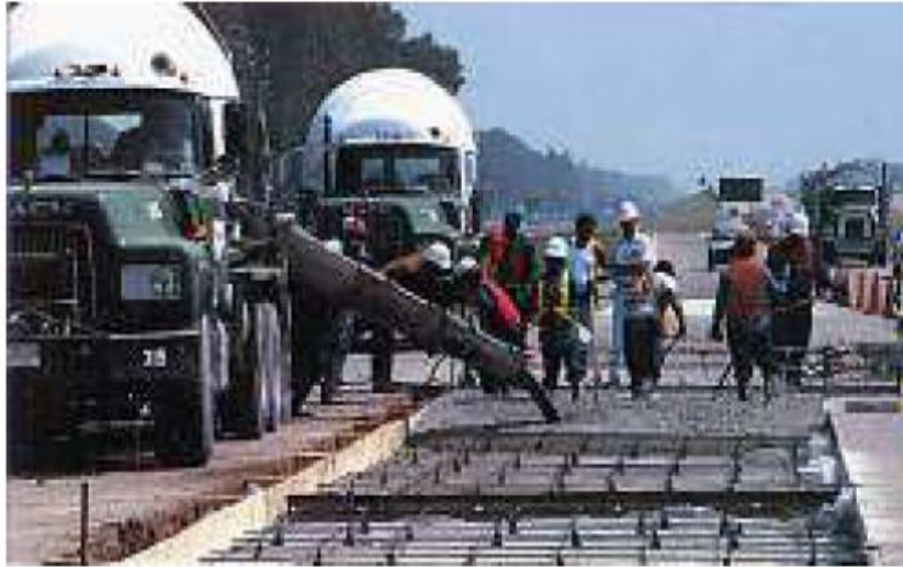
Figure I-21 : Rénovation de route avec le ciment Pyrament® ( www.geopolymer.org ).
