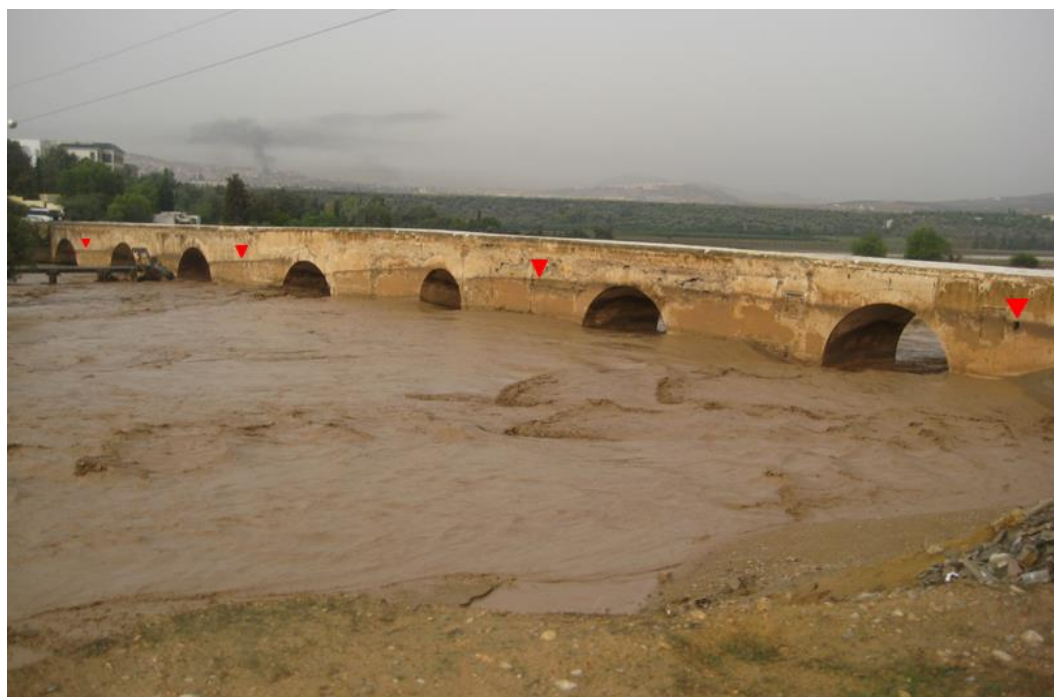
Photo 4. Le pont portugais pendant la crue du 10-11/10/2008. Les triangles en rouge indiquent le niveau maximal atteint par les eaux de la crue. (ABHS)
