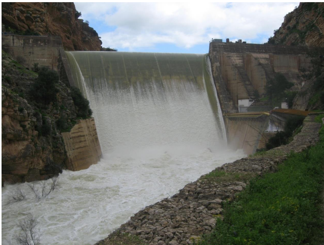
Photo 2. Déversement du barrage El Kansera en février 2010 (ABHS)
