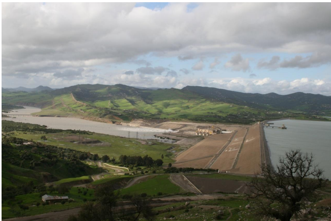
Photo 1. Déversement du barrage Al Wahda en février 2010 (ABHS)
