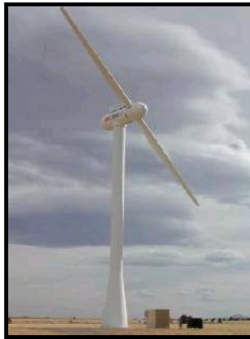
Figure A.1 : Eolienne CART au NWTC, Golden, Co [Sto04]
