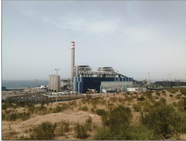
Photo n° 7 : Centrale thermique de la ville de Safi
