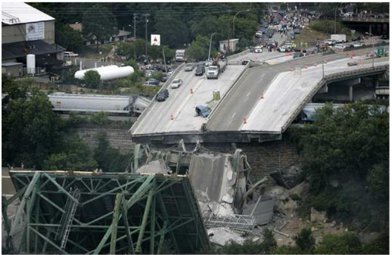
Fig. 31 : Effondrement de la Portion Nord du pont 35W. Les débris ont atteint 1.6 km de longueur
