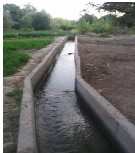
Photo 22 : Exemple de Séguia en béton armé
