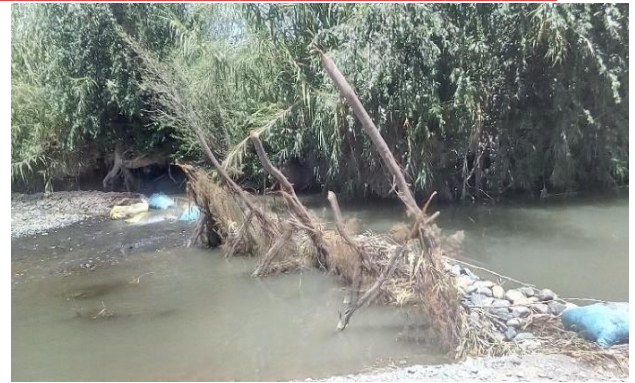
Photo 20 : Exemple de barrage traditionnel (Ouggou) utilisé pour le transfert de l'eau de l'Oued vers les Séguias
