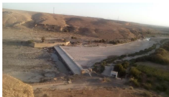
Photo 26 : Digue de transfert des eaux vers le séguia de Guercif (14 mai 2017)
