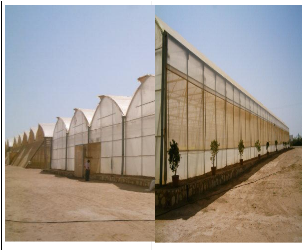
Figure 2. 2 : Ouvrants d'aération aux parois latérales et zénithales au toit
