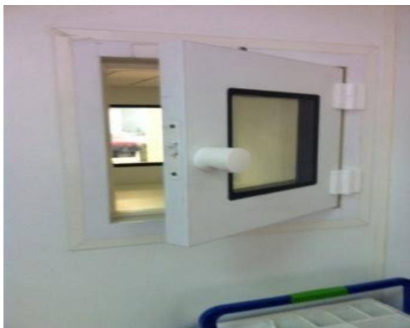
Figure 3: fenêtre séparant la réception à la salle d'aliquotage et de tri (Laboratoire de virologie HMIMV)
