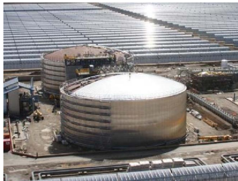
Figure II-3 Stockage de sel fondu dans deux réservoir en Andasol I (Sattler.J s.d.)
