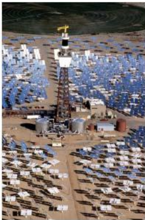
Figure II-12 Stockage direct à deux réservoirs de l'usine "Solar Two", Barstow, États-Unis (Sattler.J.s.d.).
