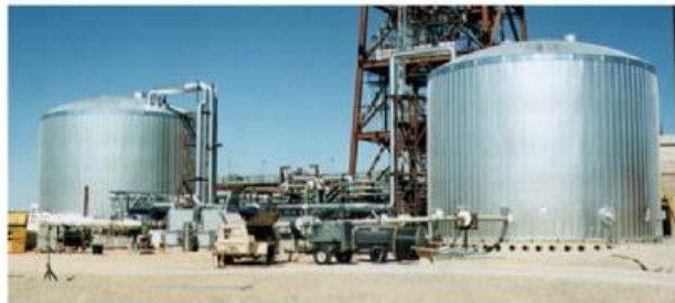
Figure II-12 Stockage direct à deux réservoirs de l'usine "Solar Two", Barstow, États-Unis (Sattler.J.s.d.).
