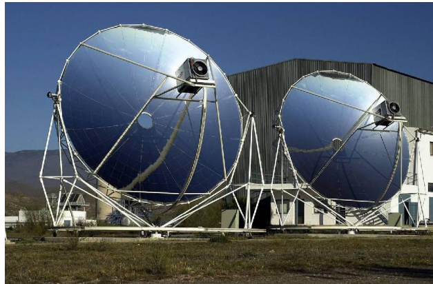
Figure I-3 Unités de Dish-Stirling installées à la Plateforme Solaire d'Almería en Espagne (LETCHER.M 2013)
