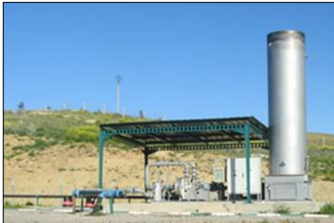
Figure III.10 : Torchère de la station bioélectrique de la décharge de Fès.
