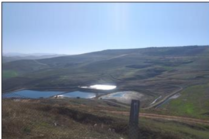
Figure V.2 : Vue générale sur les bassins de stockage des lixiviats de la décharge publique contrôlée de Fès.
