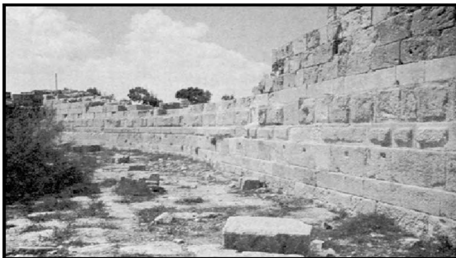
Fig. 9. - Face orientale du môle oriental avec, au premier plan l'aire dallée et, creusés dans la paroi arrière du portique, les points d'amarrage (photo A. Laronde).
