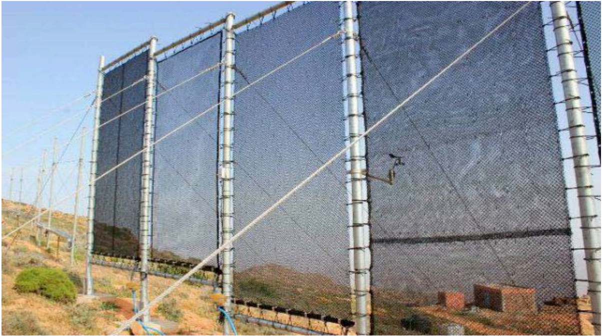
Figure 33 : Filets qui capturent le brouillard pour le transformer en eau à Sidi Ifni
