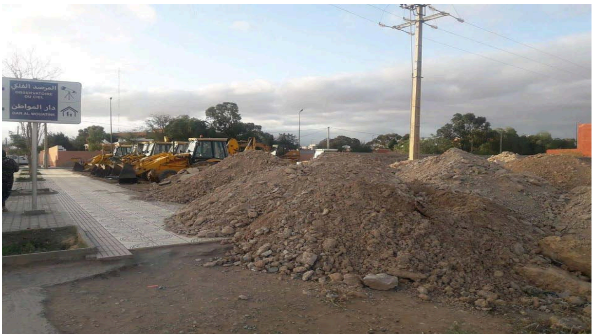
Figure 29 : Chantier routier en cours de réalisation à Guelmim
