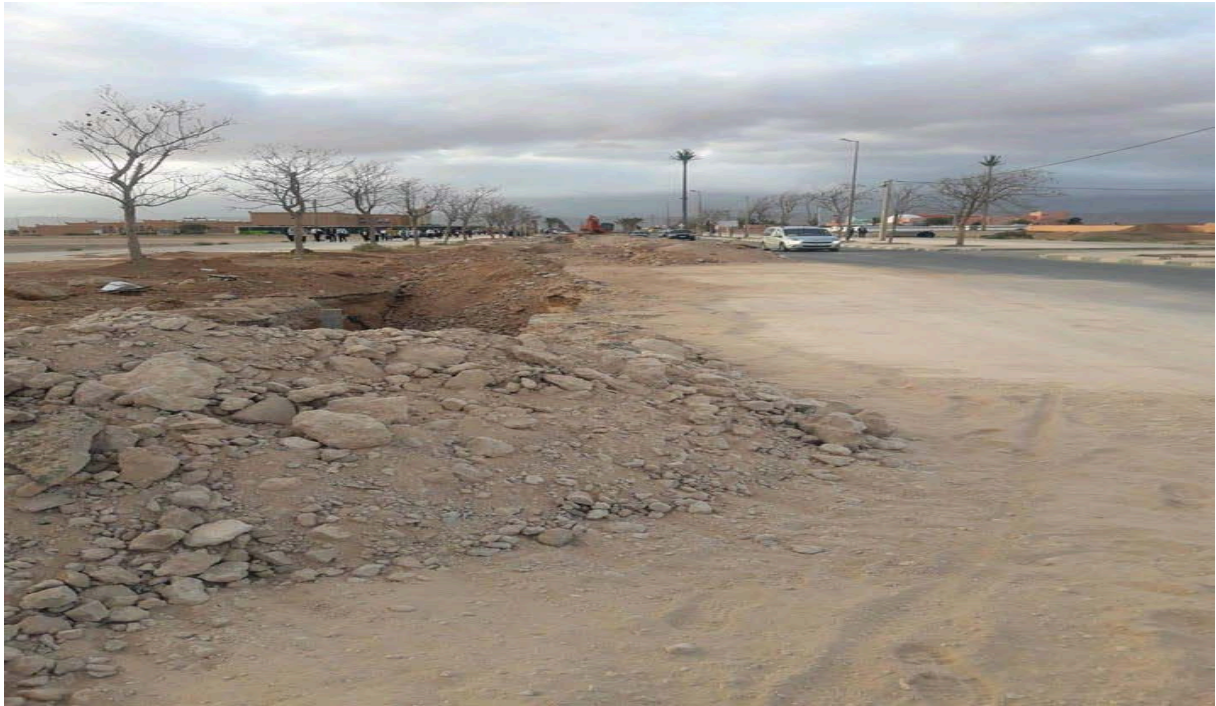
Figure 30 : Chantier immobilier en cours de réalisation à Tantan
