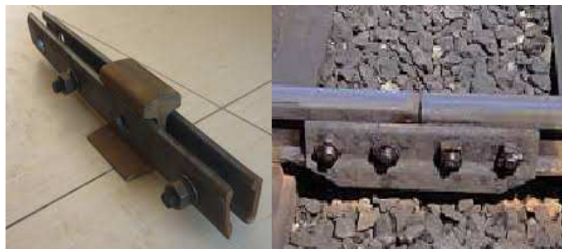
Figure 2.8 : Éclisse pour rails de chemin de fer.
