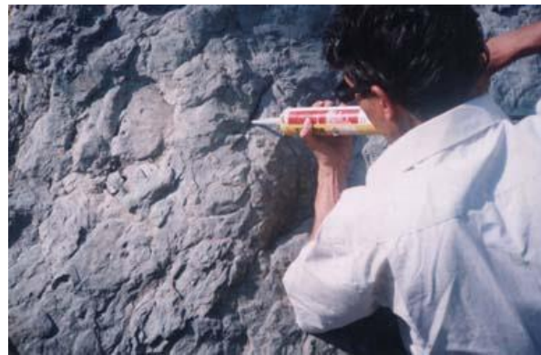
Figure 70 : Colmatage par injection de silicones, la Rioja.
