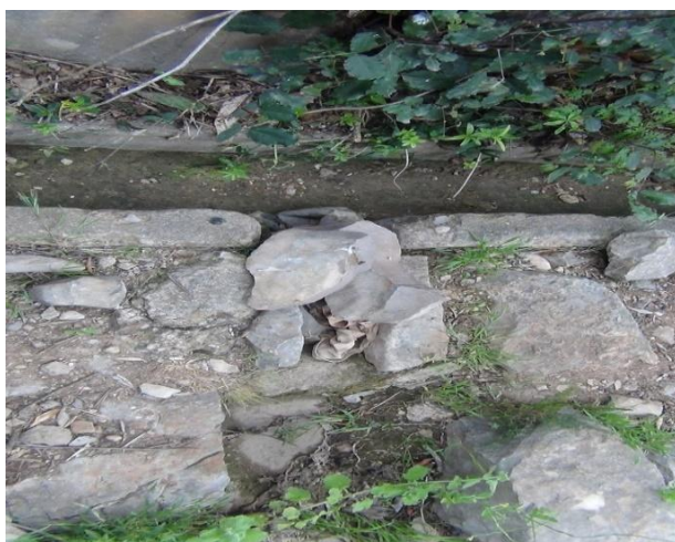
Photo. 24. Construction archaïque d'une séguia en ruine à douar Guemguem. (Le chercheur, le 13 avril 2019)
