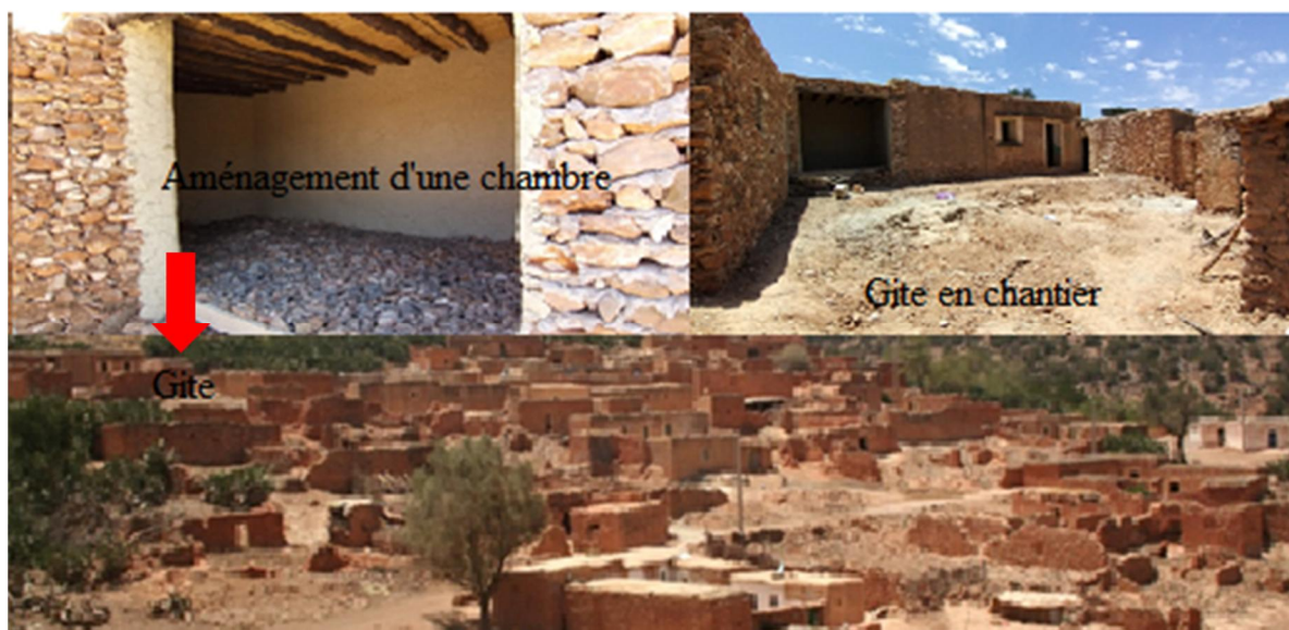
Photo. 68. Construction en cours d'un gîte à Boumia (douar presque totalement abandonné) Source : le chercheur. Le 17 avril 2019
