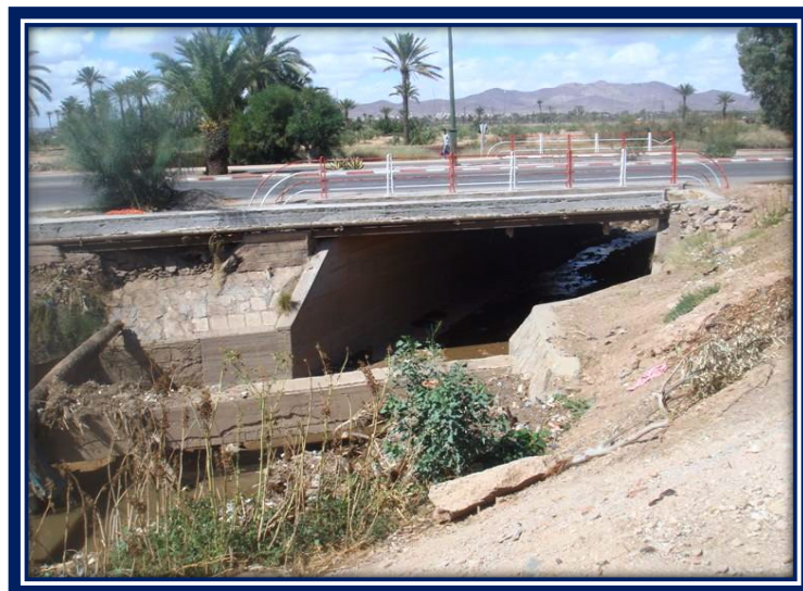
Photo 29 : Pont sur la route vers Casablanca
