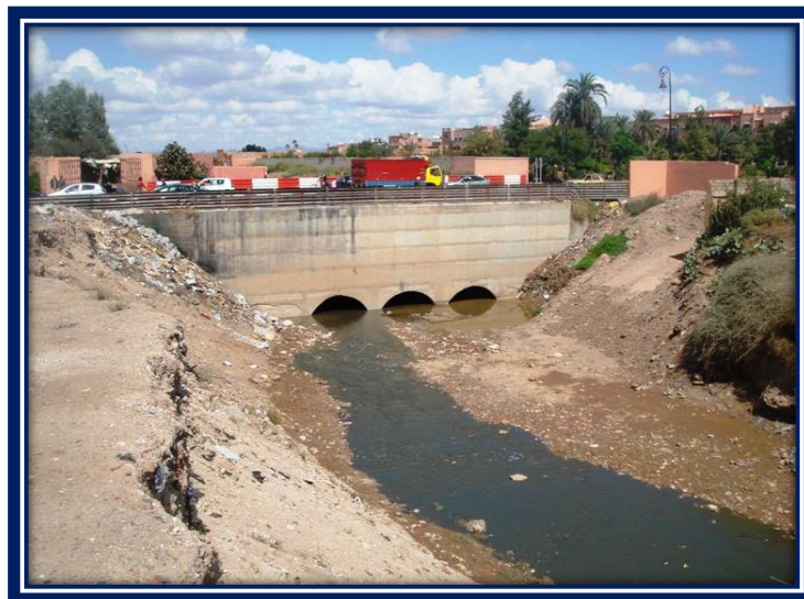
Photo 27 : Pont sur la route RP24 vers Fès
