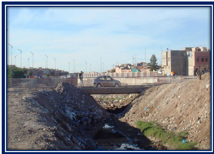
Photo 23 : Pont 1 Lotissement Fekhara
