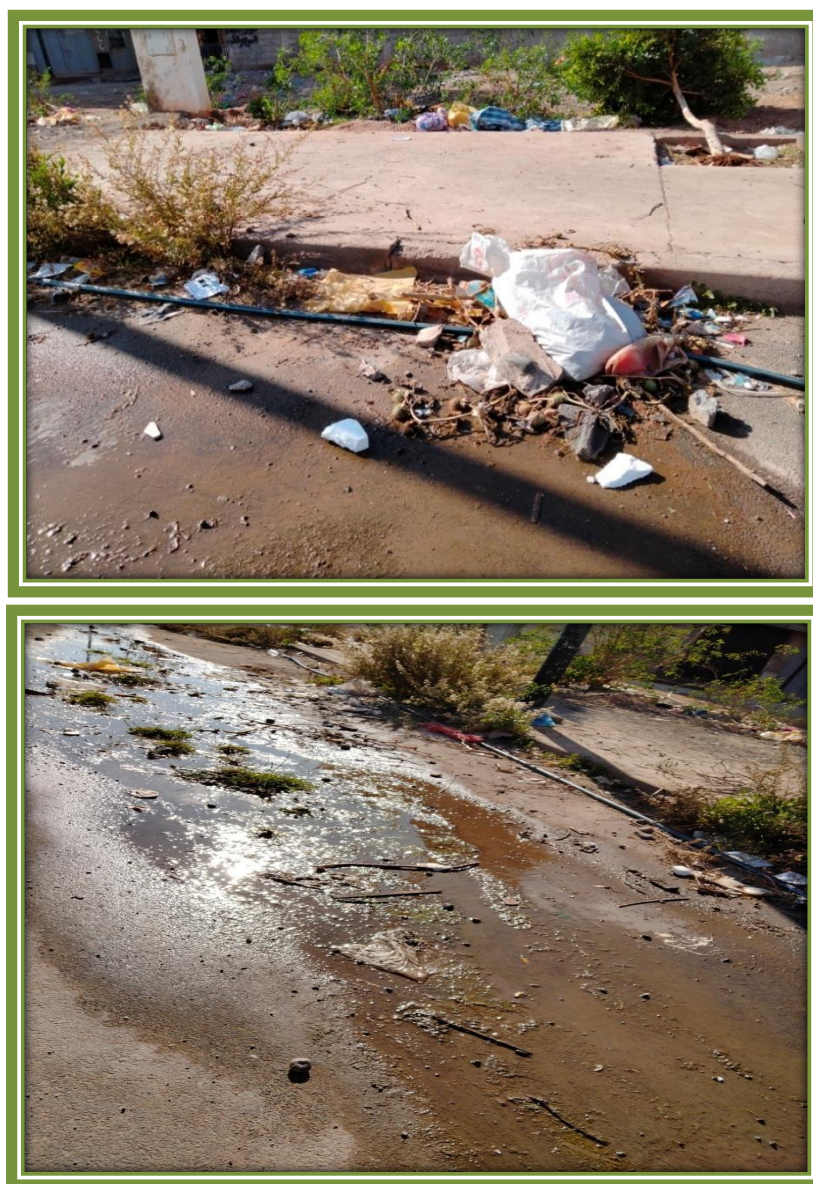
Photo 41 : L'état des égouts de l'eau potable
