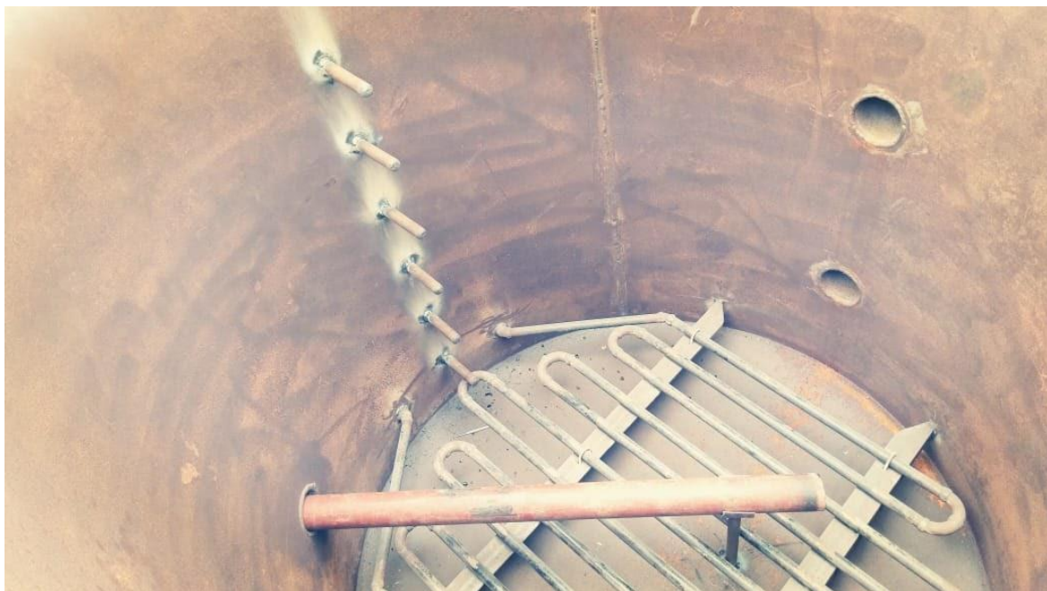
Figure IV-3 : Réservoir du bitume vu de l'intérieur.
