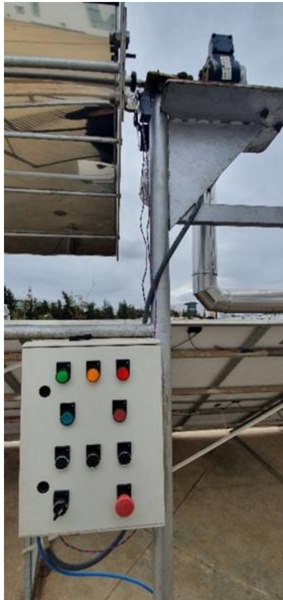
Figure IV-17: Système de suivi du micro cylindro parabolique
