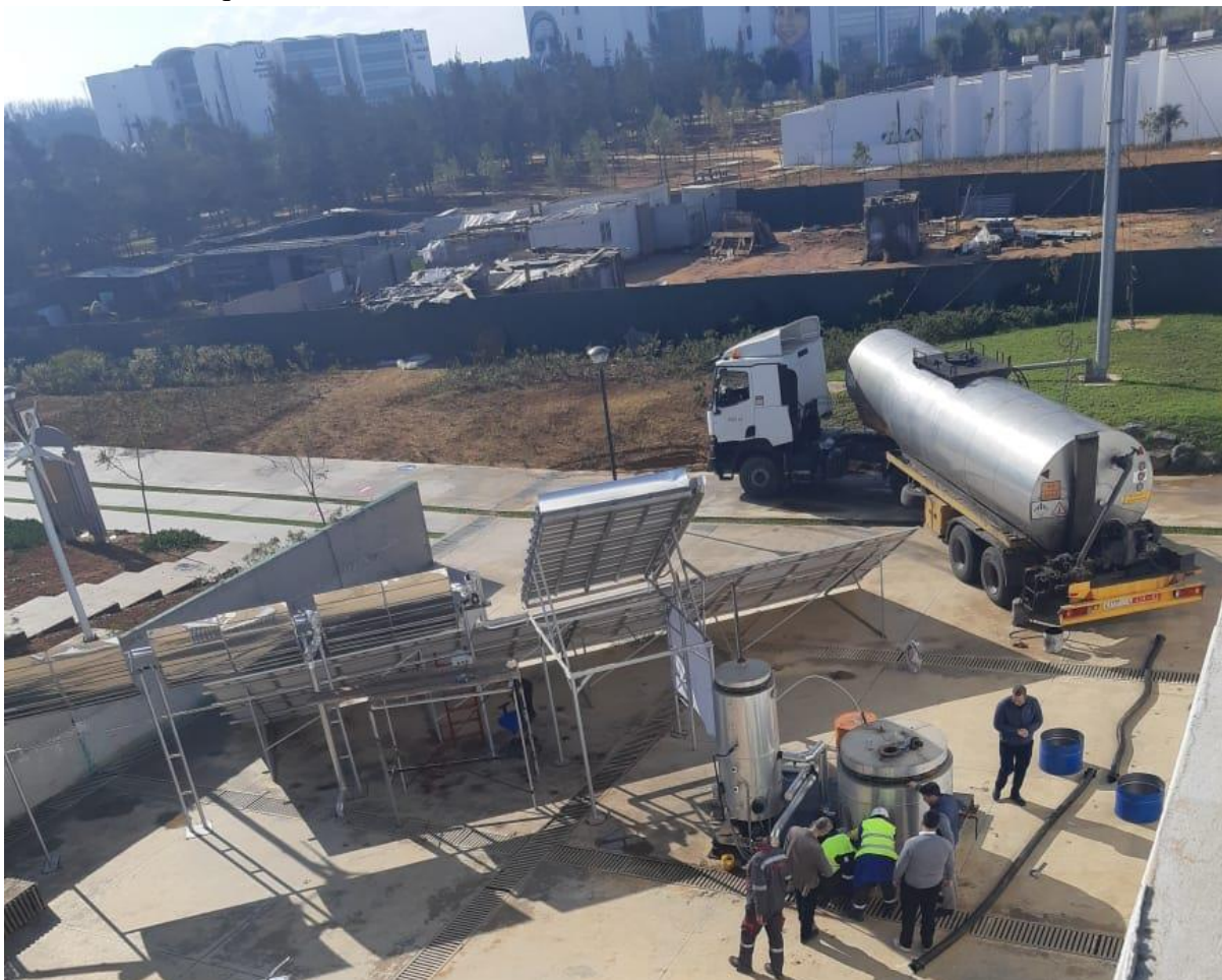
Figure IV-13: Remplissage du réservoir par le bitume 30/50
